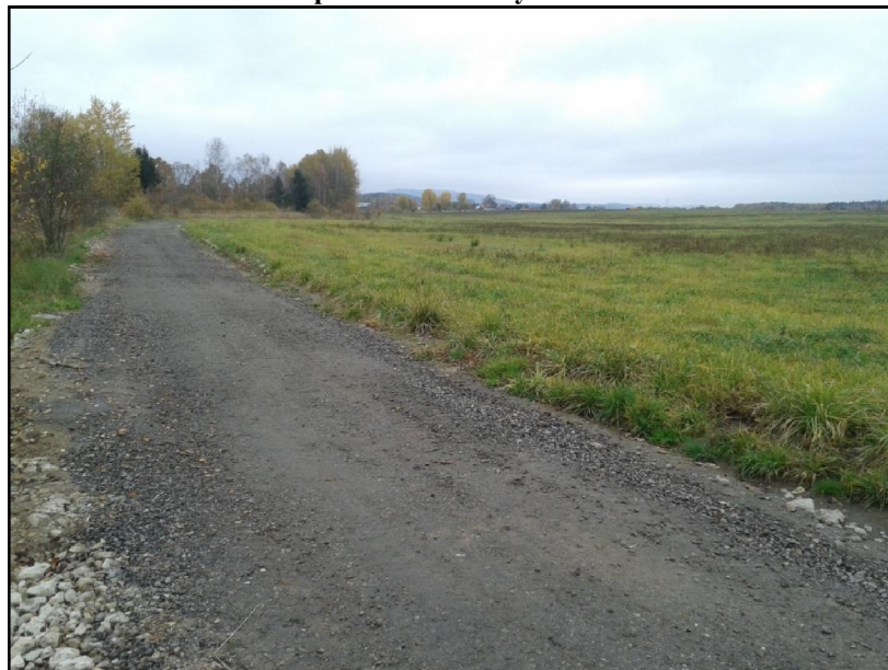
Obrázek 15: Realizace zasakovacího pásu ZP 1 a cesty PH 2
