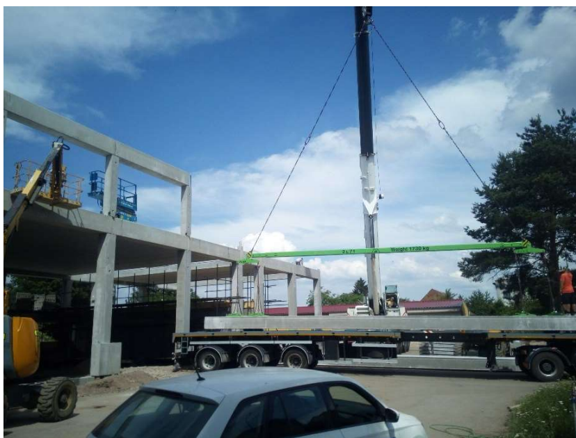
Obrázek F.7.2.6-1 – Montáž předpjatých stropních panelů (zdroj [autor])
