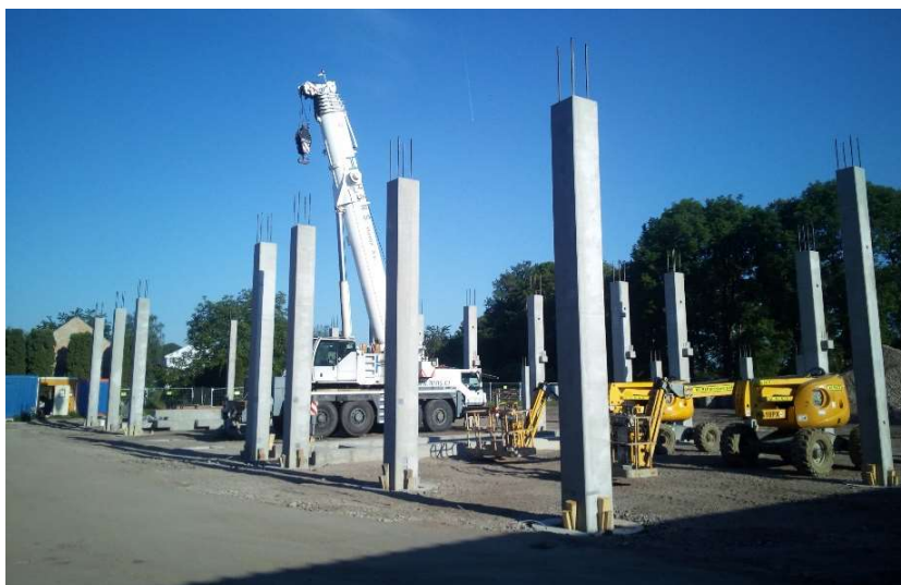
Obrázek F.7.2.1 – Montáž sloupů 1NP (zdroj [autor])
