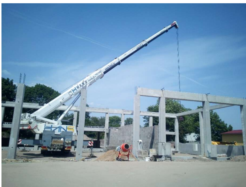
Obrázek F.7.2.4-1 – Montáž průvlaků (zdroj [autor])
