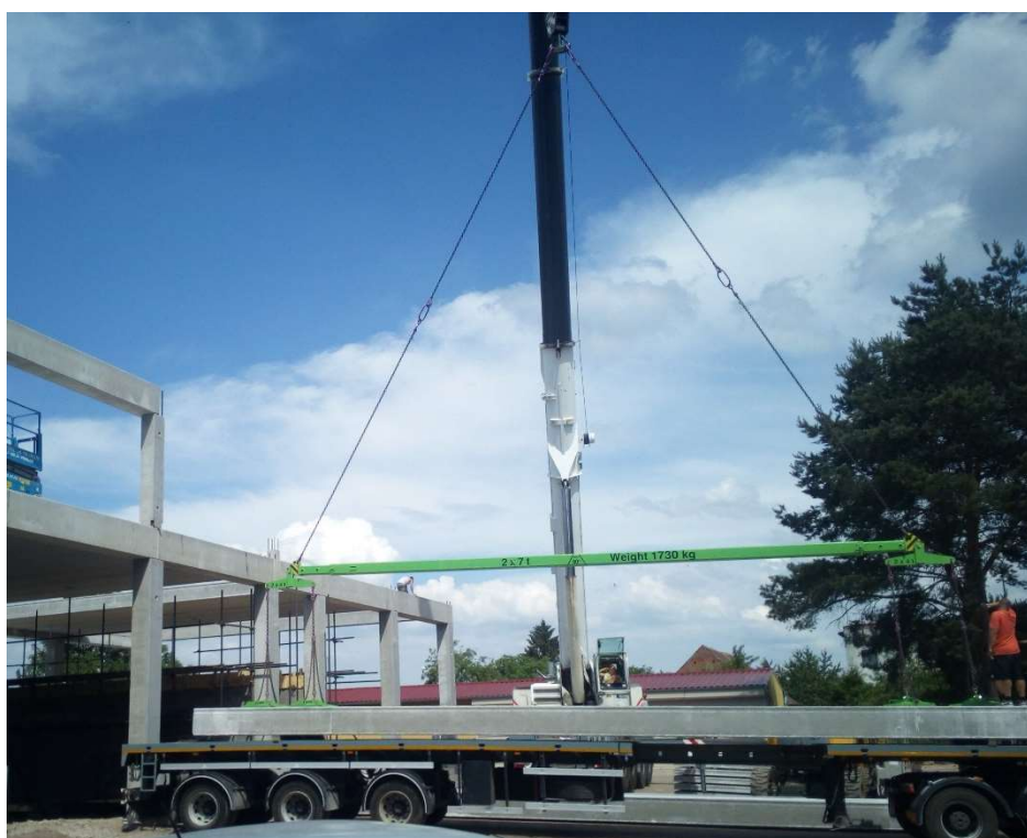
Obrázek G.2.4.6 – Samosvorné kleště na ocelovém nosníku (zdroj [vlastní])
