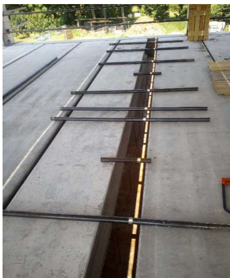
Obrázek F.7.2.6-2 – Bednění dobetonávky mezi stropními panely (zdroj [autor])
