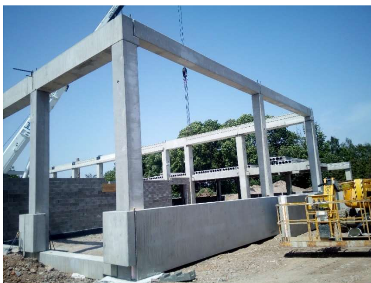
Obrázek F.7.2.5 – Montáž ztužidel (zdroj [autor])
