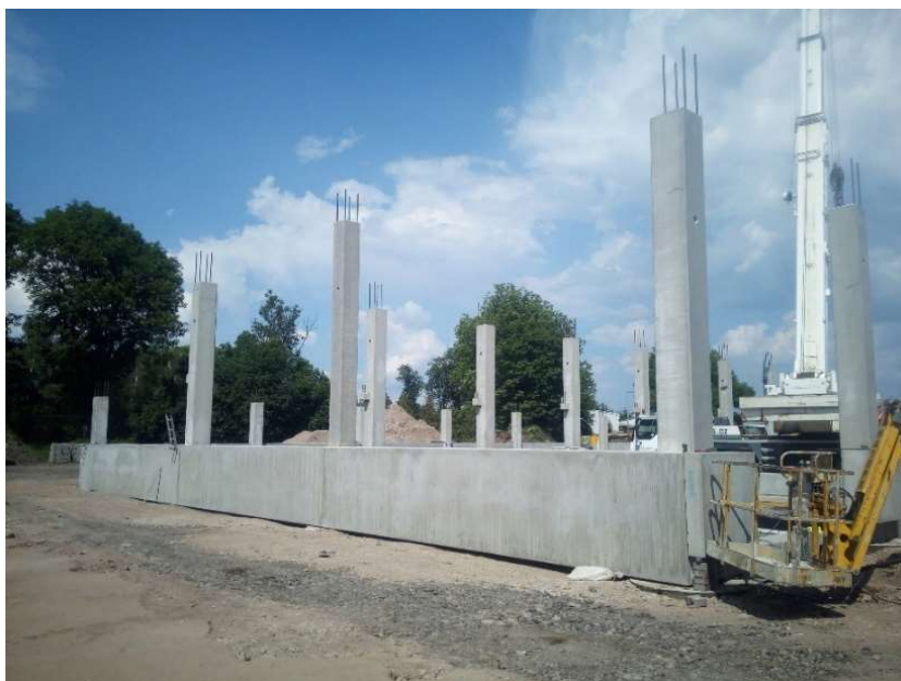
Obrázek F.7.2.3 – Montáž soklových panelů (zdroj [autor])
