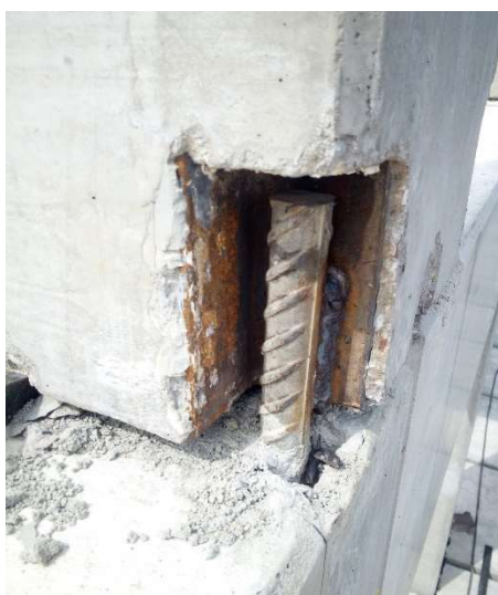
Obrázek F.7.2.7 – Svarový spoj sloupu 2NP (zdroj [autor])
