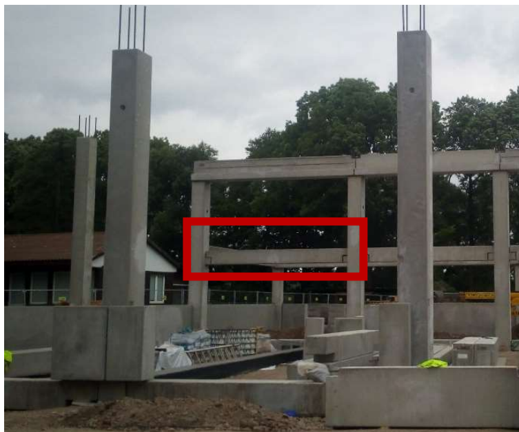
Obrázek F.7.2.4-2 – Montáž průvlaků na průběžné sloupy (zdroj [autor])
