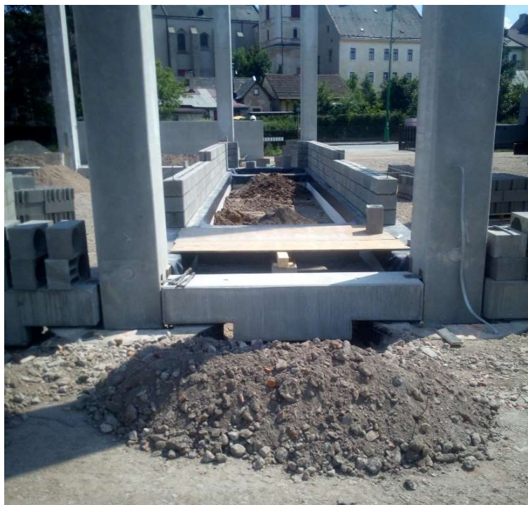
Obrázek F.7.2.2 – Montáž základových prahů (zdroj [autor])
