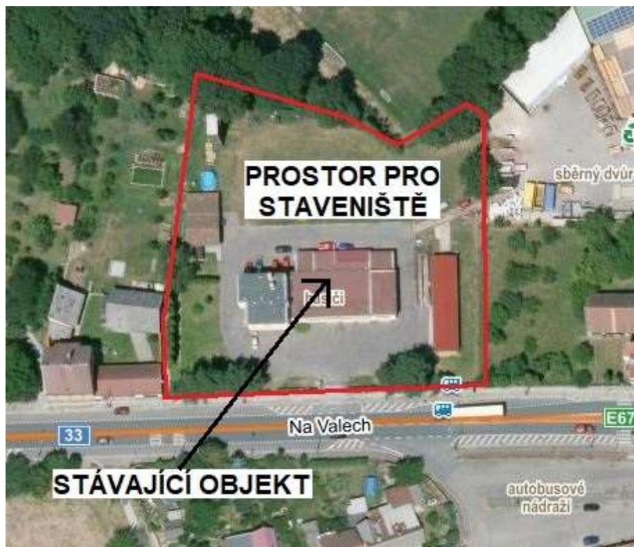
Obrázek B.3 – Prostor pro staveniště, stávající stav (zdroj [2])
