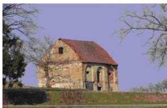
Obrázky č. 12 a 13 Špýchar před obnovou a po celkové obnově
