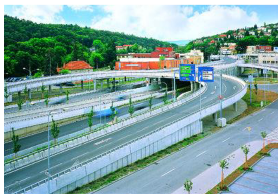
Obrázek 8 – 12 – Silnice I/42 Brno [zdroj: www.ohlzs.cz]
