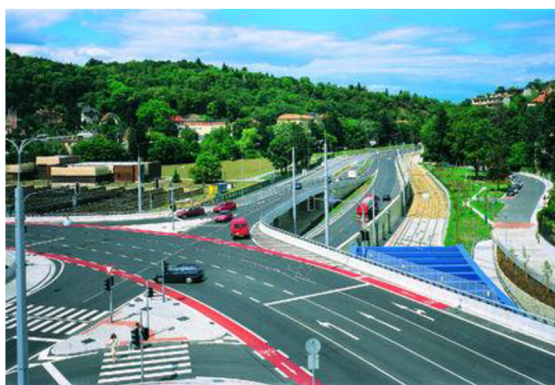
Obrázek 8 – 11 – Silnice I/42 Brno [zdroj: www.ohlzs.cz]
