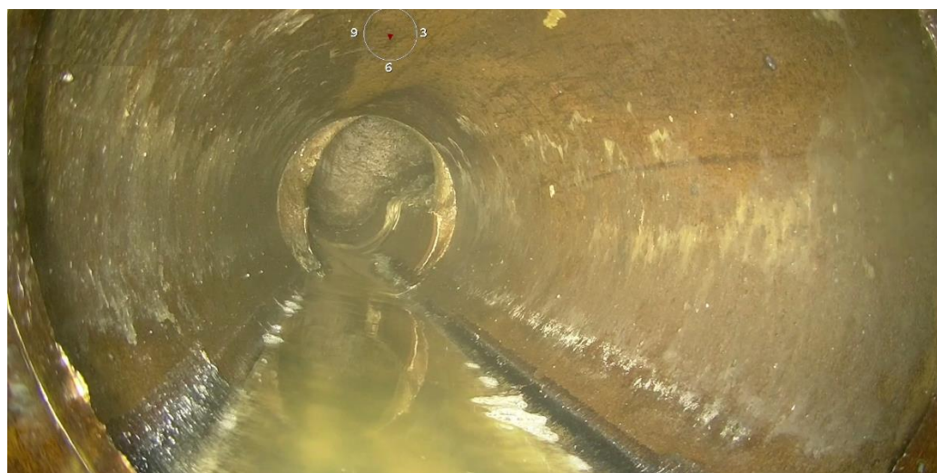
Obr. 40 – 45.78 m – Konec potrubí [BVK, a.s.]
