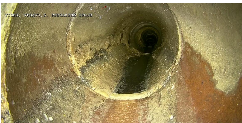
Obr. 31 – 22.40 m – Výšek vpravo, přesazené spoje [BVK, a.s.]
