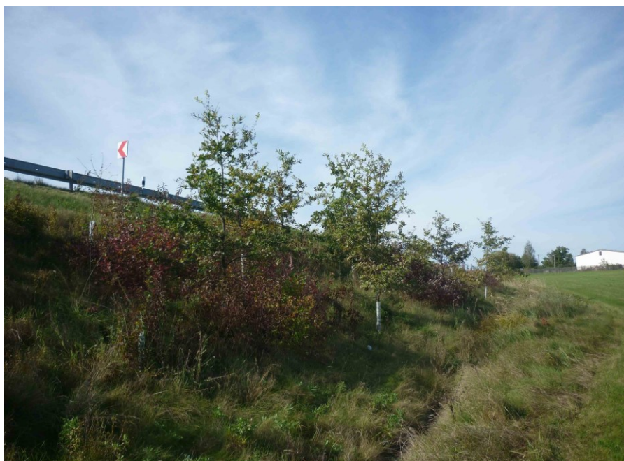
Foto č. 50 – Vegetační prvek č. 5 – Osázení svahu vzniklého postavením mostu s místní komunikací přes dálnici D3.
