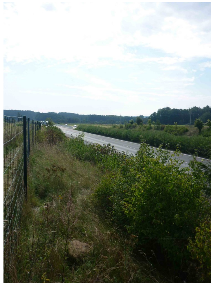
Foto č. 6 – Vegetační prvek č. 5, 6, 23 – Výsadby na svazích podél obou směrů dálnice D 3 a vegetační pás Amorpha fruticosa (VP 23) mezi jednotlivými směry dálnice.
