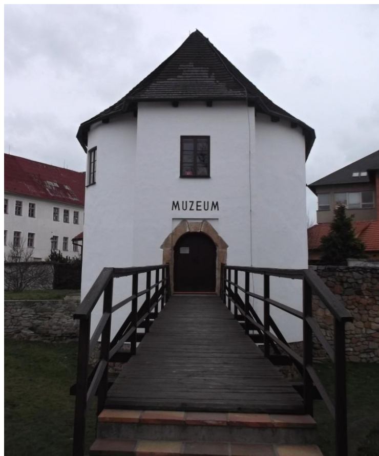
47. Uničov, Vodní branka, pohled na průčelí s rizalitem
