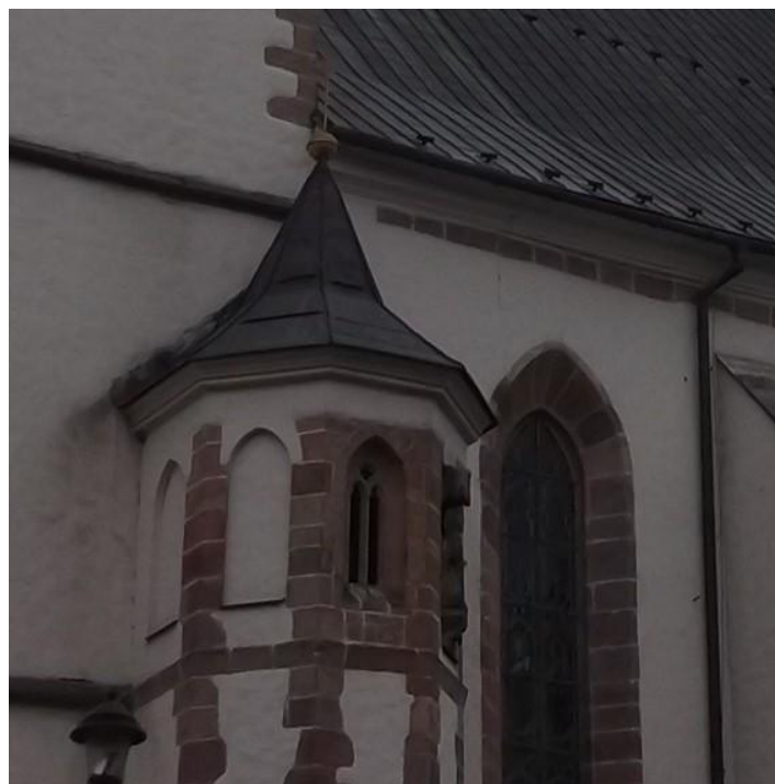
12. Uničov, kostel Nanebevzetí Panny Marie, lomené okno s kružbou v horní části vřetenového schodiště
