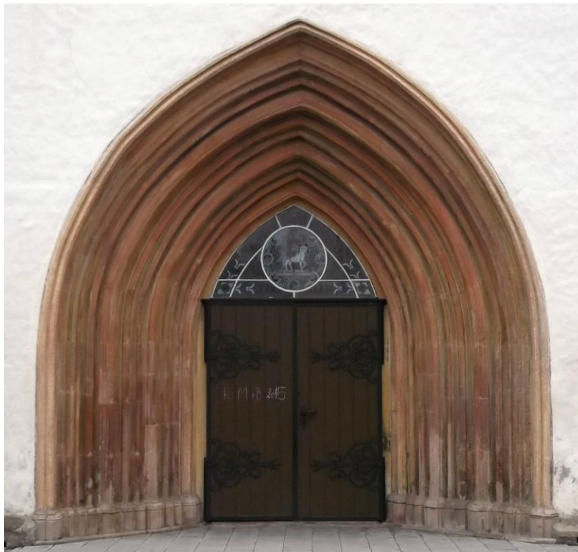
9. Uničov, kostel Nanebevzetí Panny Marie, hlavní portál na západním průčelí kostela
