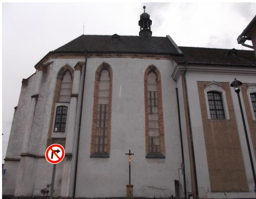
16. Uničov, bývalý kostel Povýšení sv. Kříže, severní strana presbytáře se zazděnými gotickými okny s fragmenty kružeb ve vrcholech
