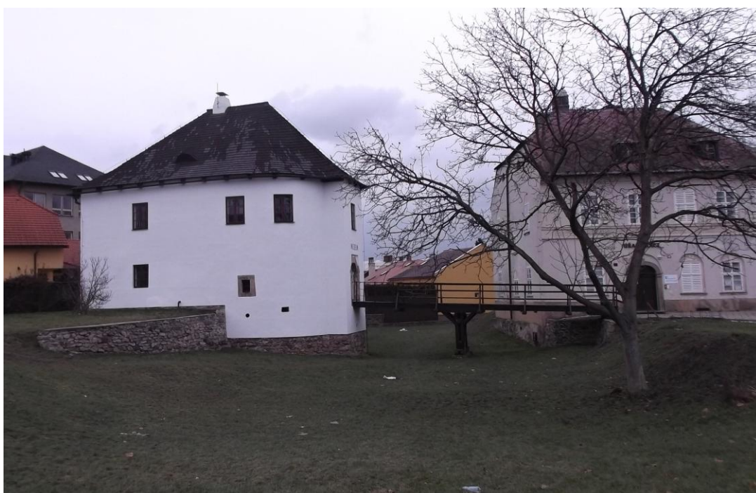
48. Uničov, Vodní branka, boční pohled na branku s pozůstatky vodního příkopu
