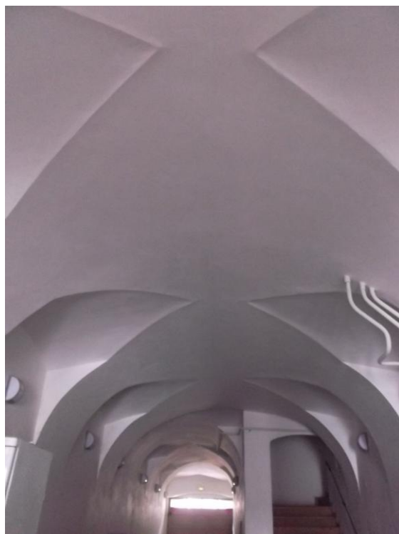
33. Uničov, Městský dům č. p. 29, valená klenba s lunetami v průjezdu
