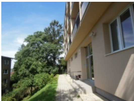
Obr. 6.7 – Pohľad na vchod bytu
