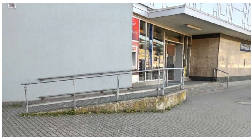
Obrázek 67 - Druhý vchod do nádražní budovy
