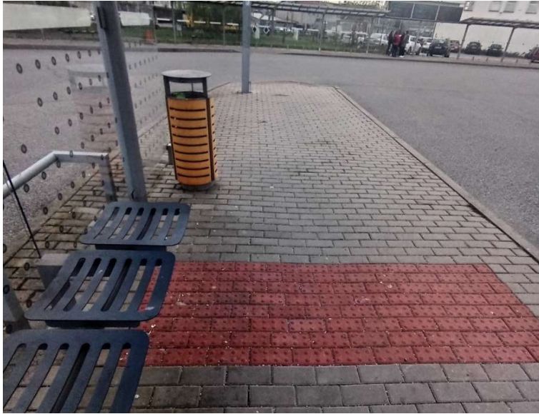
Obrázek 62 - Správné řešení signálního pásu na nástupišti VHD
