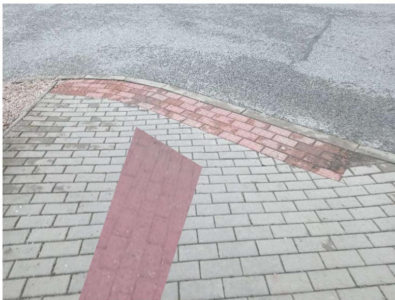
Obrázek 64 - Napojení signálního pásu k varovnému pásu
