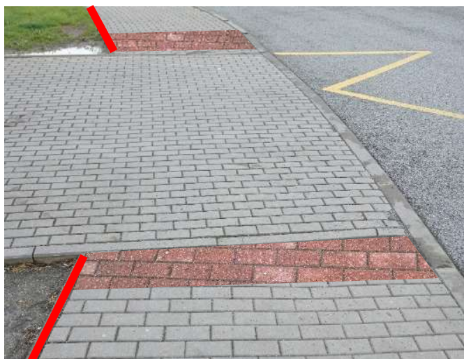
Obrázek 56 - Návrh varovných pásů
