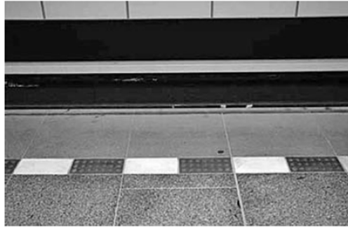
Obrázek 21 - Varovný pás na speciální dráze [Zdroj: [2]]
