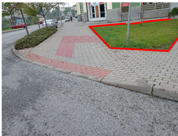
Obrázek 51 - Návrh signálního pásu a zvýšeného obrubníku
