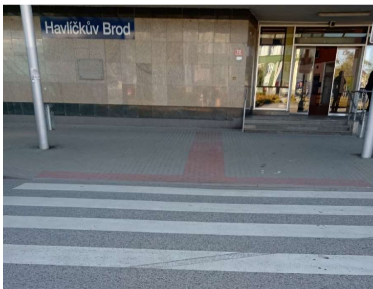
Obrázek 66 - Správné řešení přechodu pro chodce
