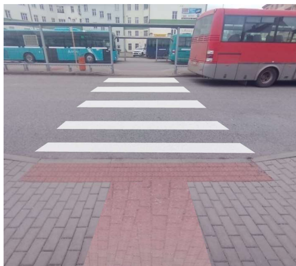
Obrázek 59 - Doplnění varovného pásu pásem signálními
