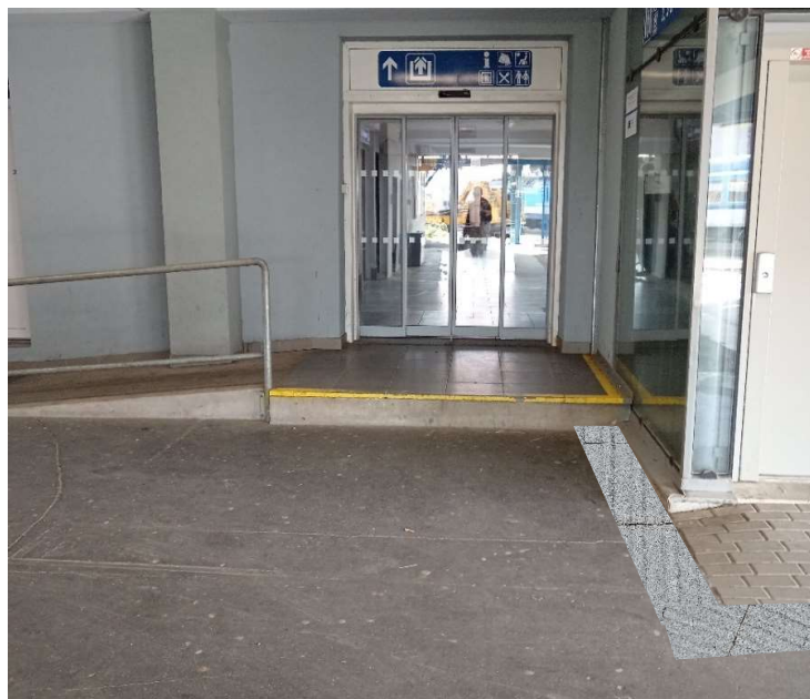
Obrázek 69 - Návrh umělé vodící linie
