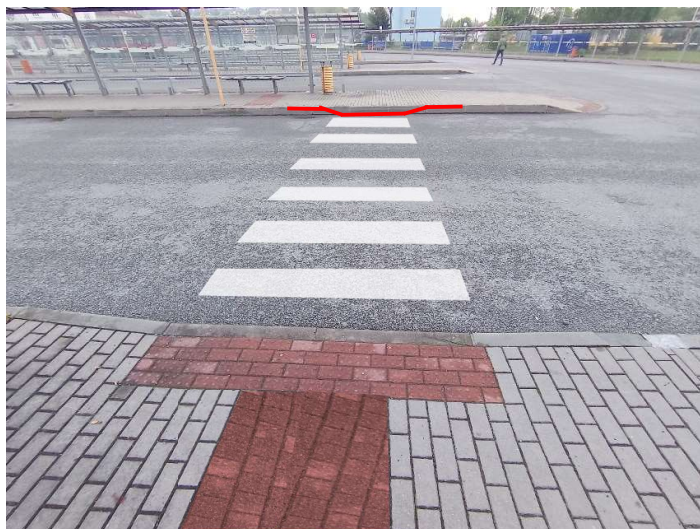
Obrázek 58 - Návrh přechodu pro chodce
