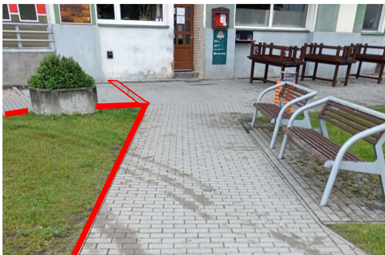
Obrázek 63 - Návrh umělé vodící linie a zvýšeného obrubníku
