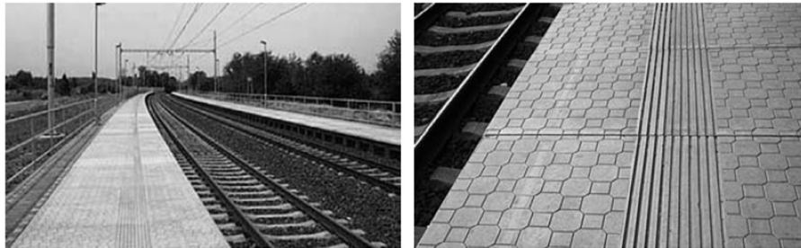
Obrázek 22 - Vodící linie s funkcí varovného pásu [Zdroj: [2]]
