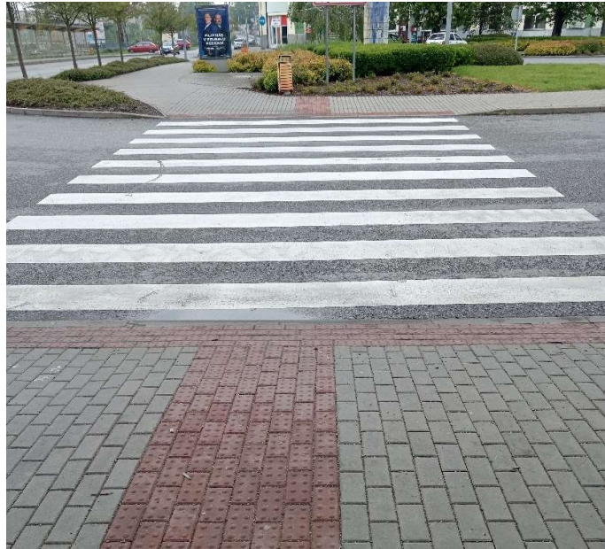
Obrázek 47 - Správné řešení u přechodu pro chodce
