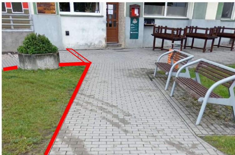
Obrázek 63 - Návrh umělé vodící linie a zvýšeného obrubníku
