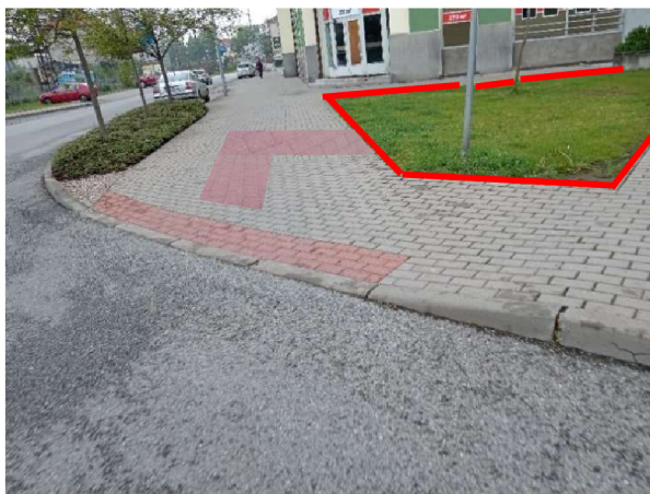
Obrázek 51 - Návrh signálního pásu a zvýšeného obrubníku
