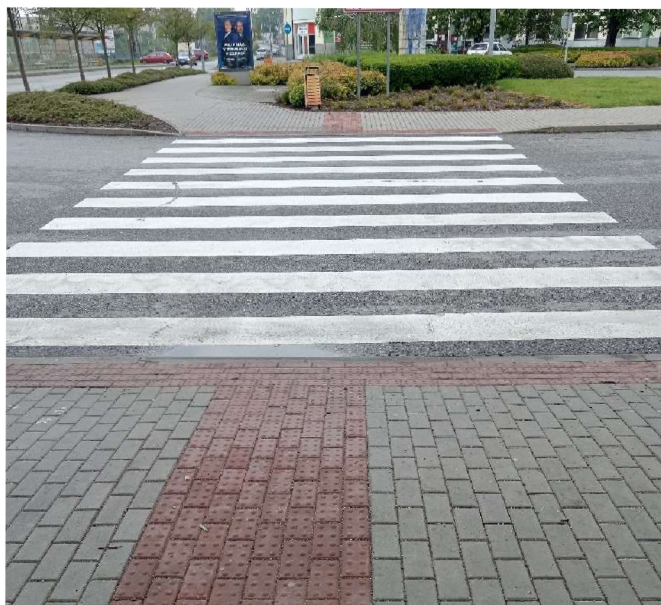
Obrázek 47 - Správné řešení u přechodu pro chodce
