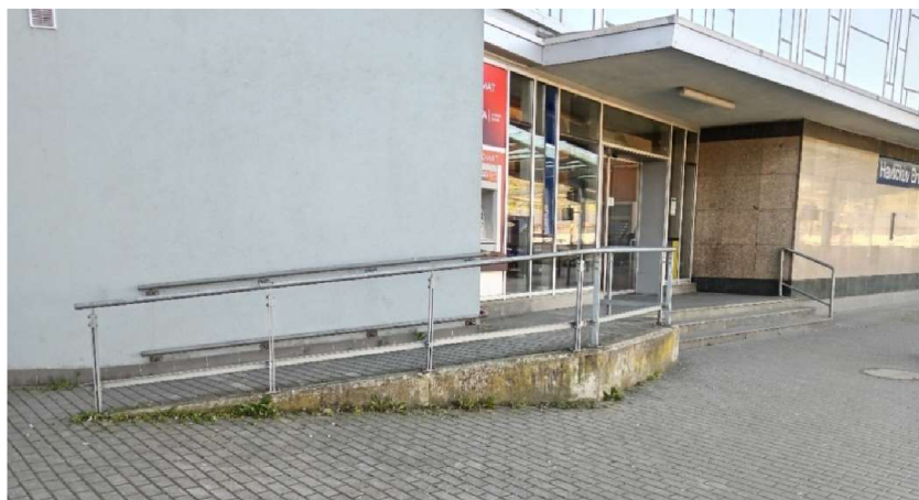
Obrázek 67 - Druhý vchod do nádražní budovy
