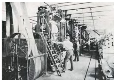
Obrázek č. 4: Hladící kalandry v Labském mlýně
