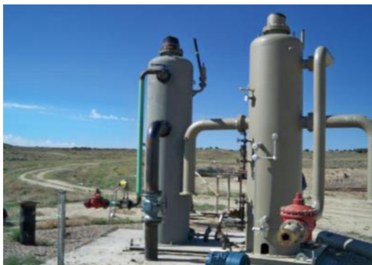
Obr. č. 3 Příklad vertikálních separátorů [7]
