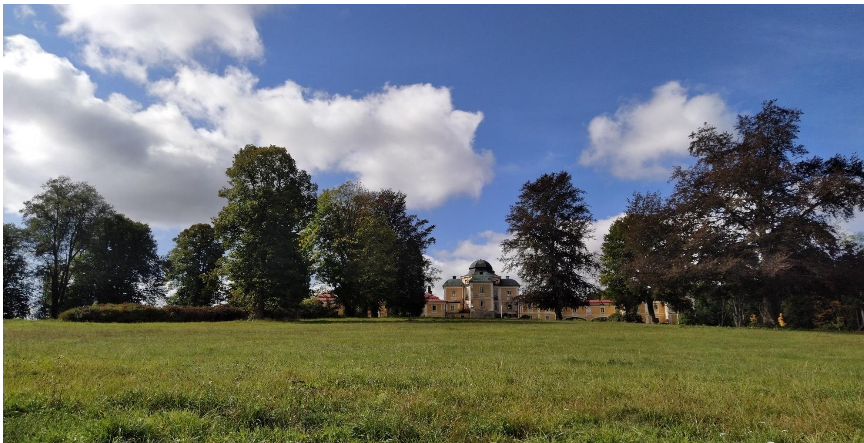
Obrázek 19: Dnešní průhled odhalující budovu zámku ze severu (Foto autorky)
