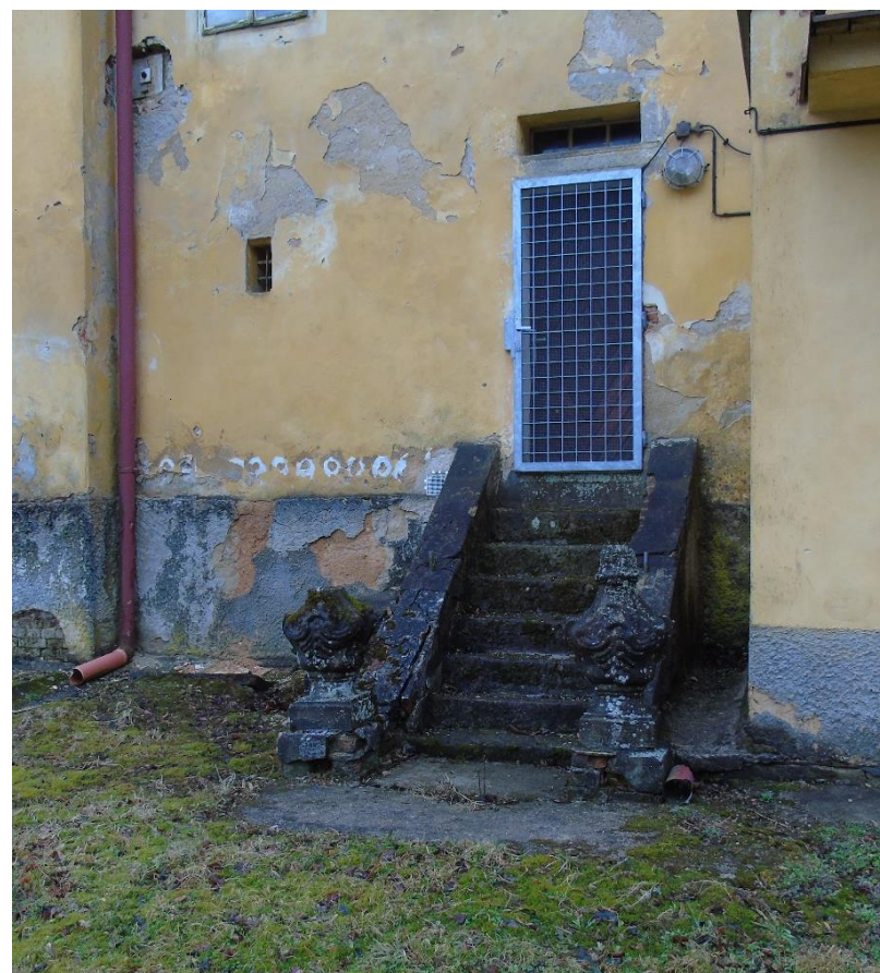
Obrázek 65: Jedno z dochovaných schodišť se sochařskou výzdobou (Foto autorky)
