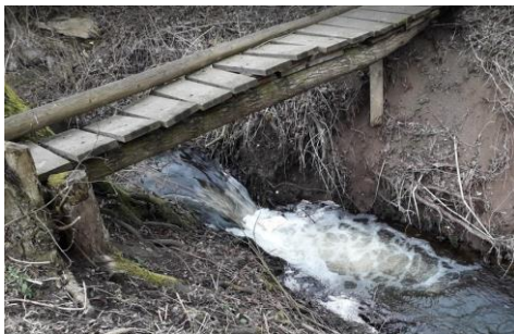
Obr. 12 L31 - provizorní lávka
