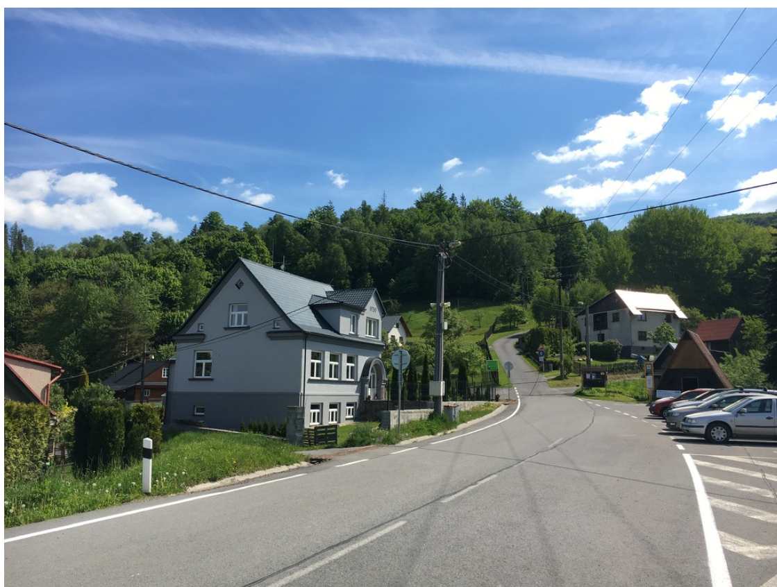
Obr. 15: Bývalá polská škola v osadě paseky 2021 (Zdroj: Vlastní fotografie)
