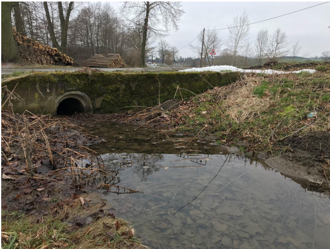
Příloha č. 6: Zanesený propustek u silnice II/105
