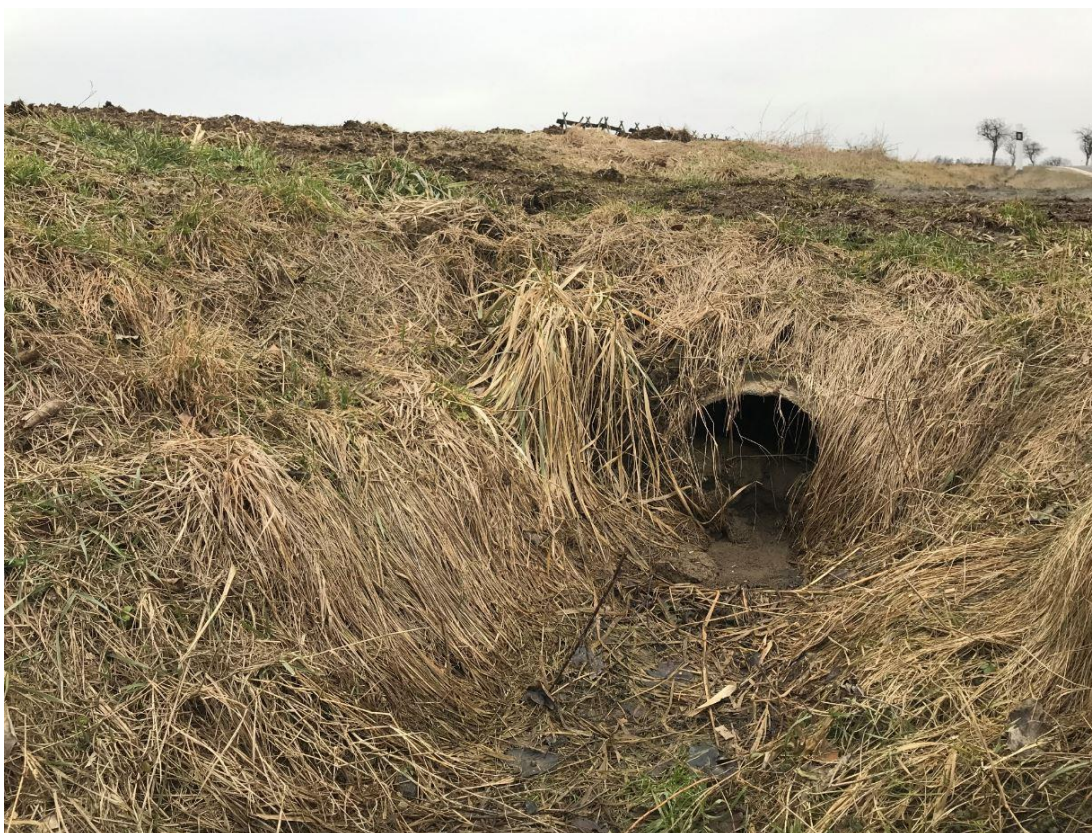
Příloha č. 6: Zanesený propustek u silnice II/105
