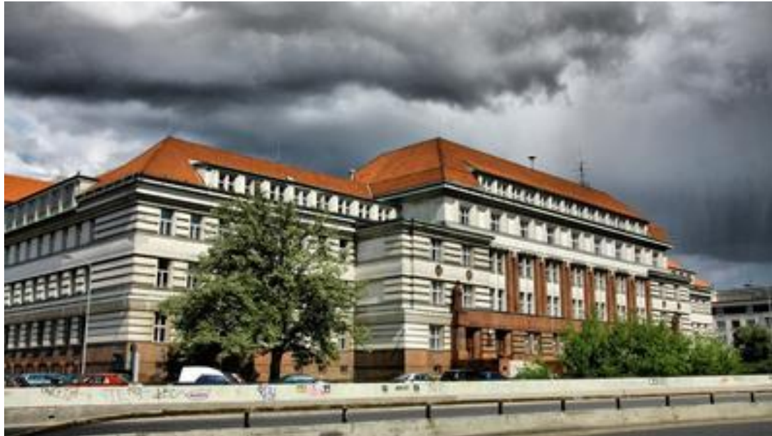
Obrázek 14: Budova Vrchního soudu v Praze od arch. Bendelmayera
