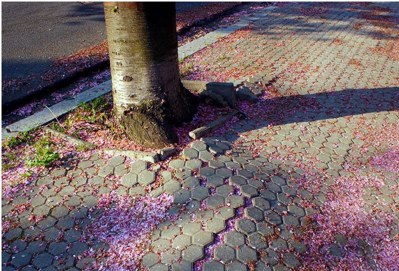
Obrázek 7: Nevhodná výsadba, strom bez vhodného přísunu vody a vzduchu
