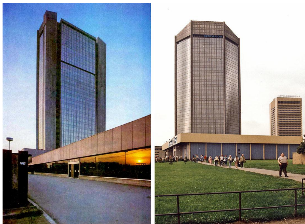
Obrázek 17: Budova bývalého Motokovu před rekonstrukcí
