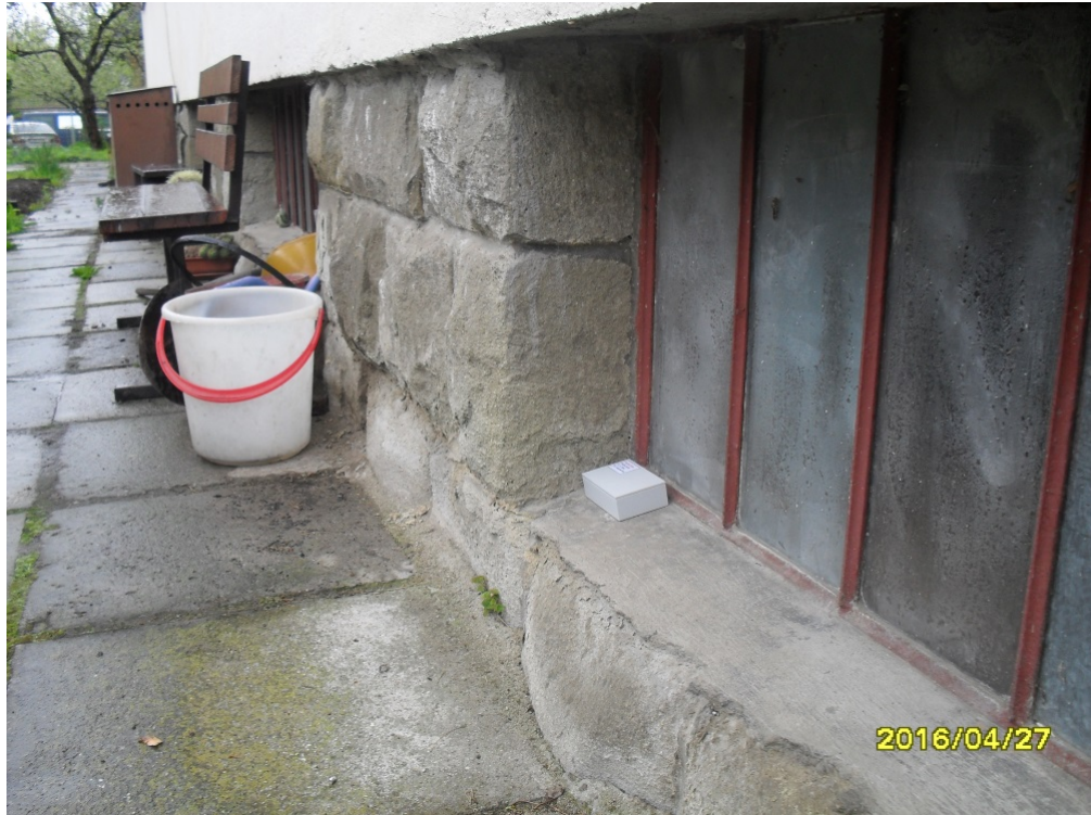
Obrázek E.7: Umístění ESP-01 pro měření teploty.
