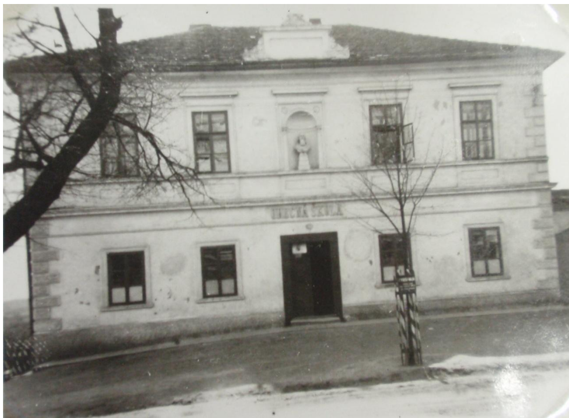
Obrázek 1 - Budova školy ve školním roce 1934/1935 232
