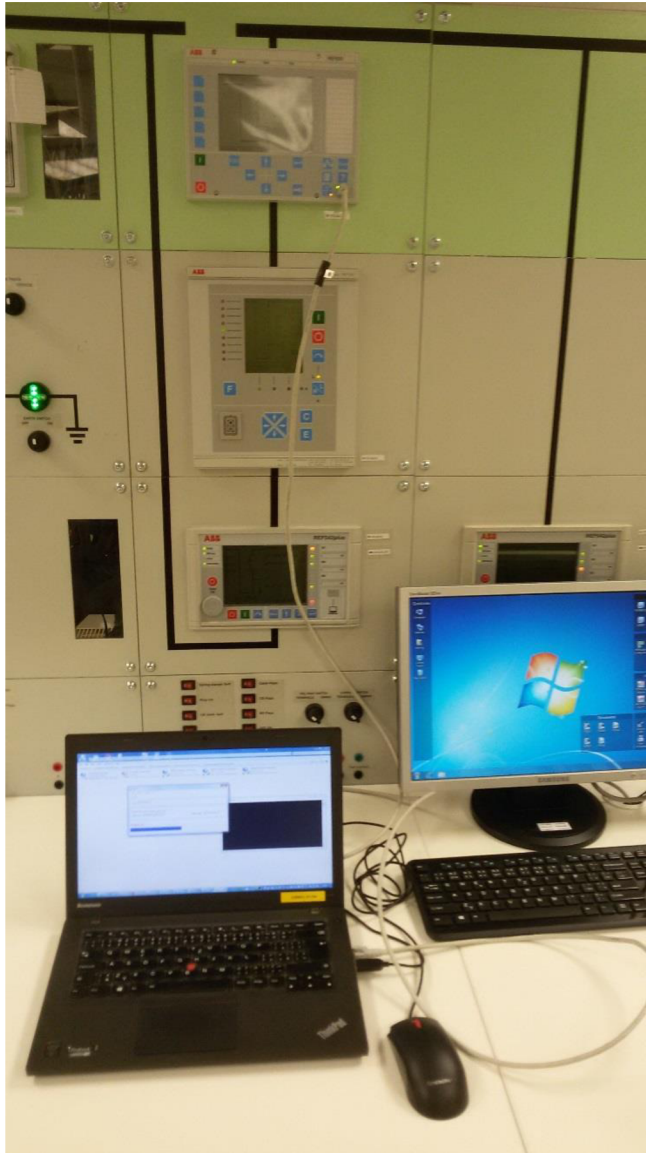
Obr. 6-5 Propojení PC s předním portem ochrany REF630
