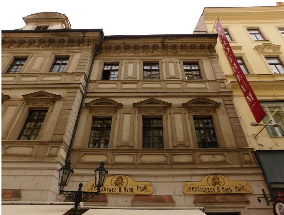
10. Praha, Kolowratský palác, po 1697, přestavba připojeného sousedního domu respektující původní výzdobu.
