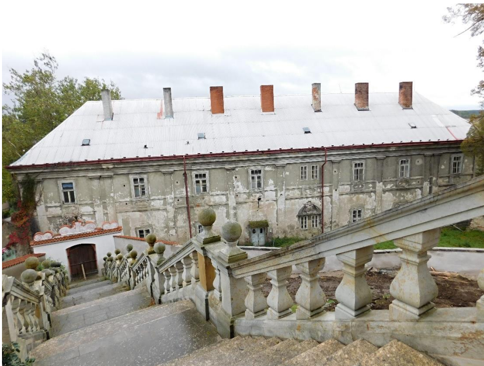
62. Andrea de Quadri (?), jezuitská rezidence v Luži, 1677–1683, pohled od chrámu.
