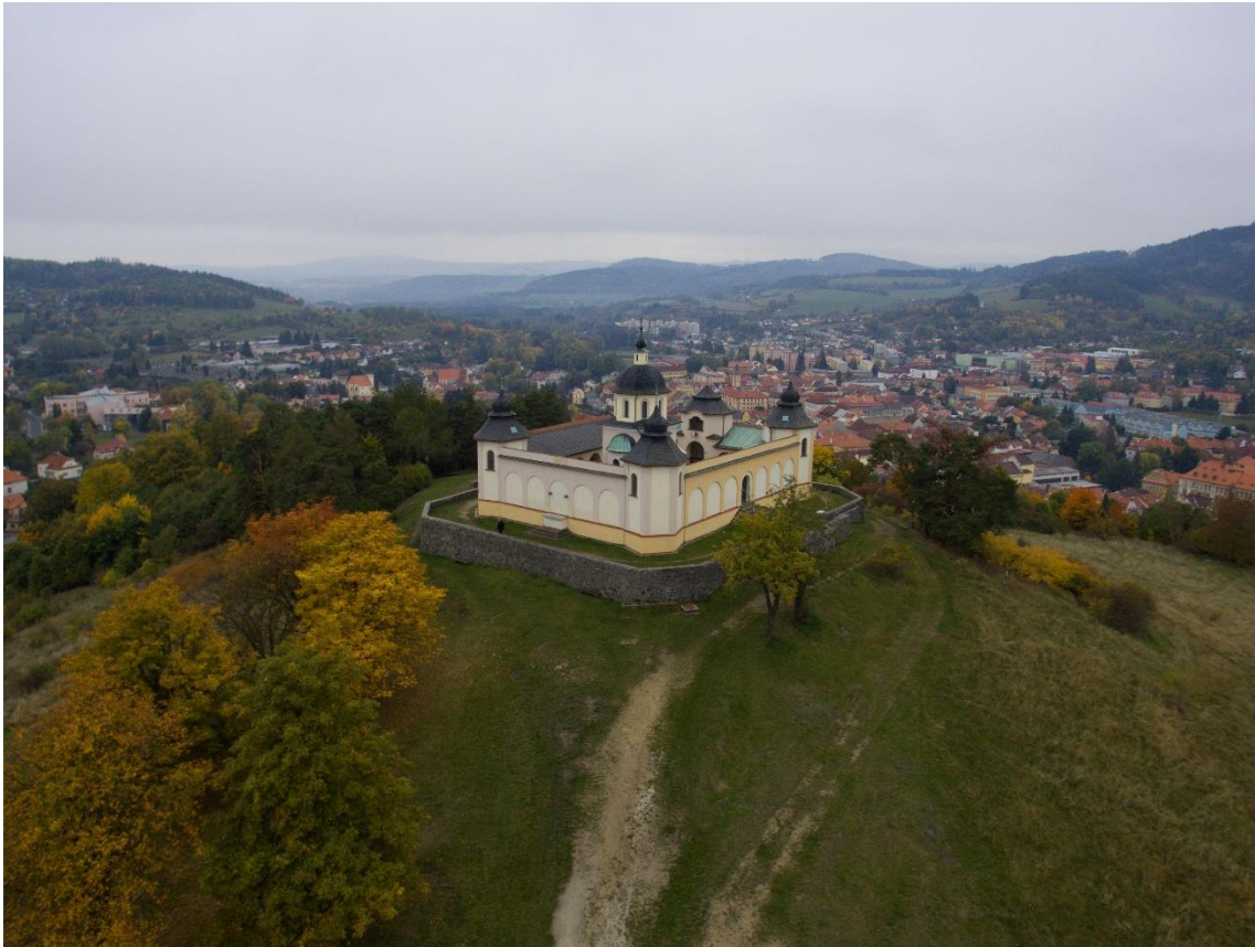
115. Sušice, poutní kaple Anděla Strážce, letecký pohled.
