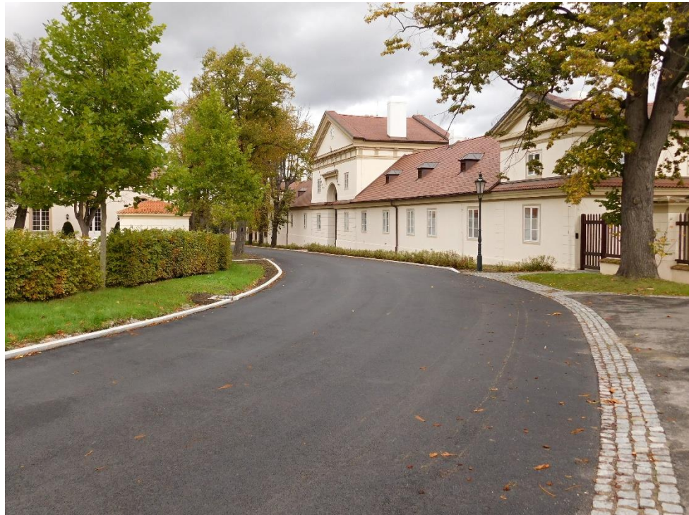
56. Žehušice, budova s průjezdní branou, 1826.
