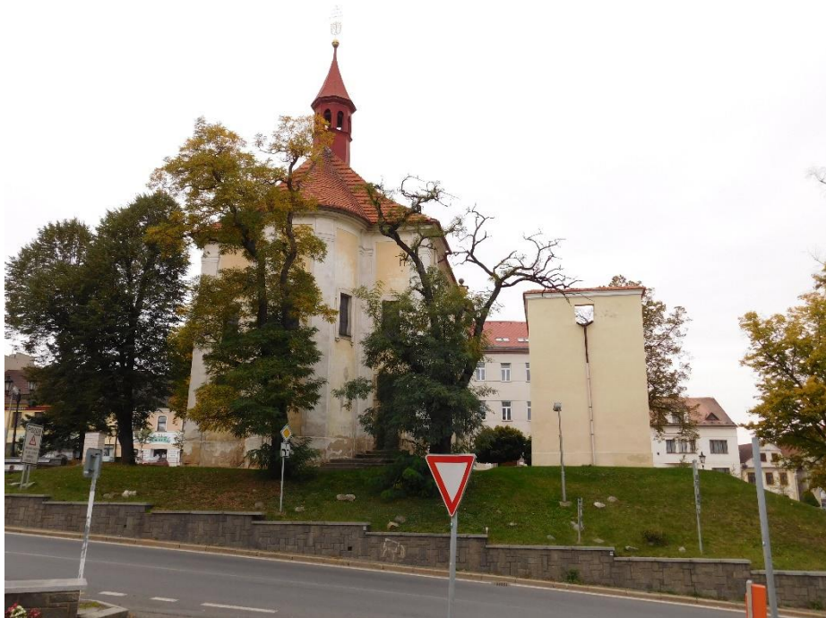
82. Hořovice, Loreta, 1685, exteriér.
