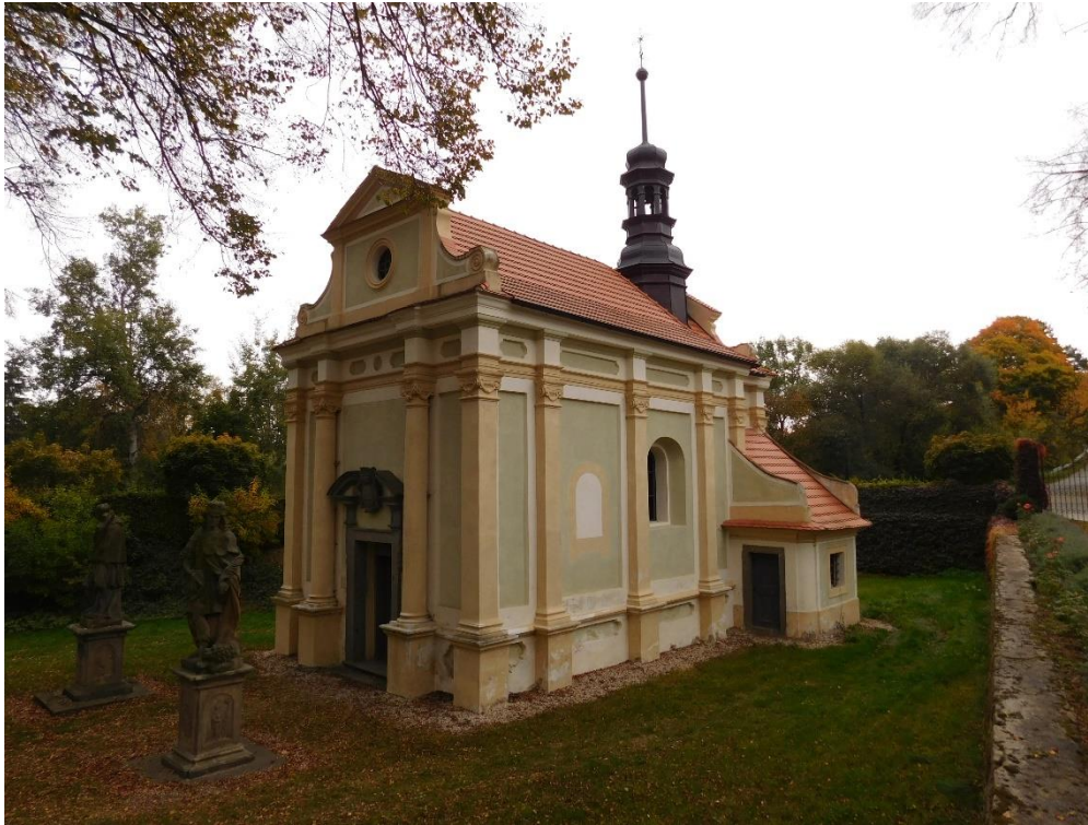
87. Radíč, Einsiedelnská kaple, 1680–1683, průčelí.
