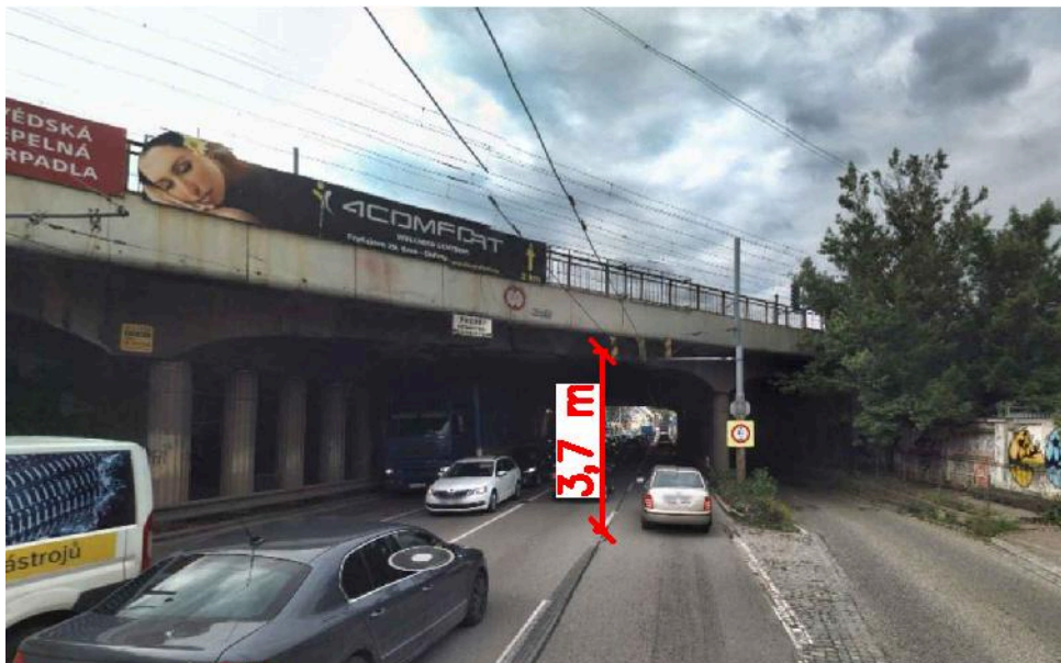
Obrázek 44 - zájmový bod F; zdroj [2] upraveno
