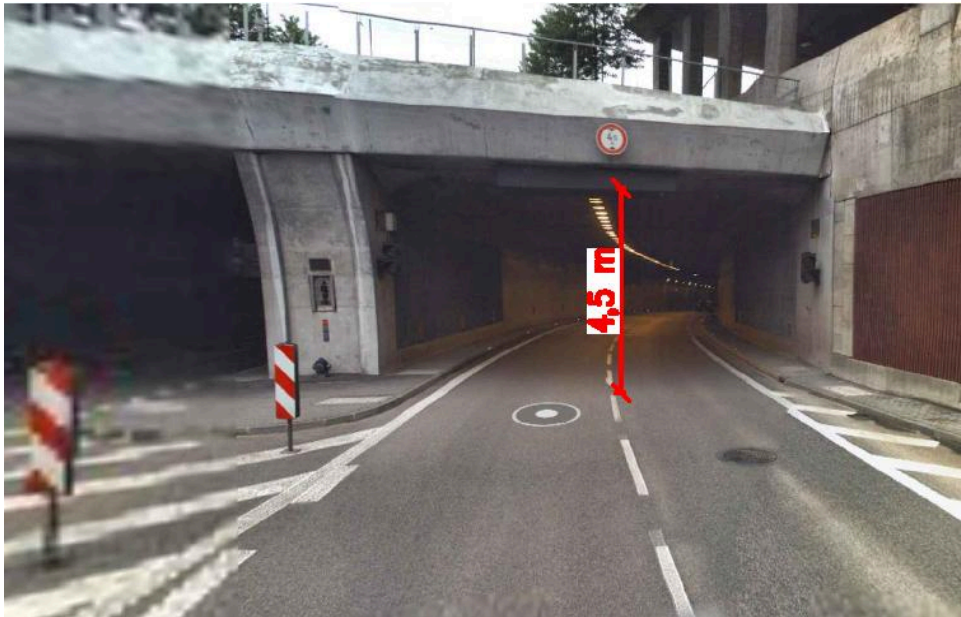
Obrázek 9 - zájmový bod F; zdroj [2] upraveno
