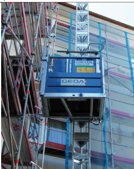
Tabulka 34 - technický popis - přepravní plošina; zdroj [17]
