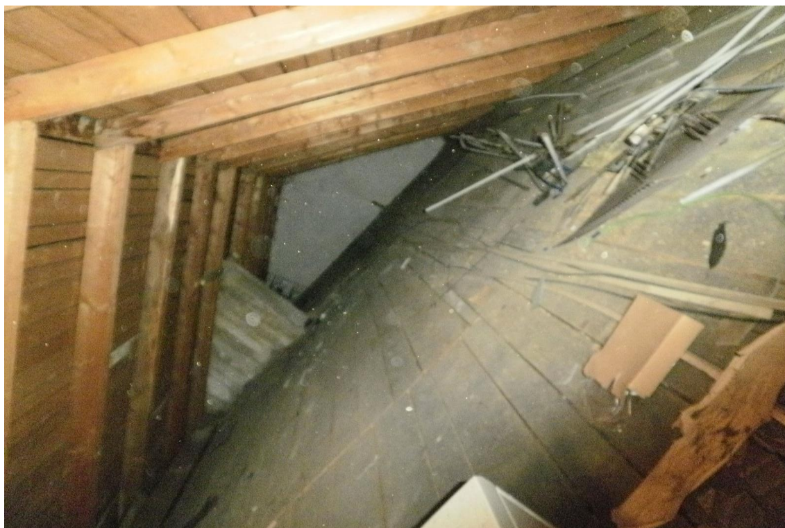
Obrázek 1-půdní prostor před začátkem stavby
