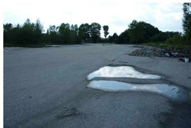
velká asfaltová plocha
