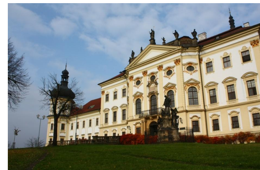
OBR. 41 VSTUP DO BUDOVY KLÁŠTERA
