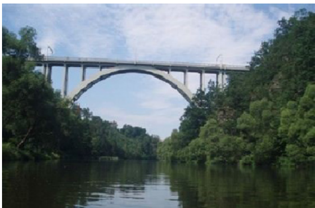
Obr. č. 30 Betonový most [28]
