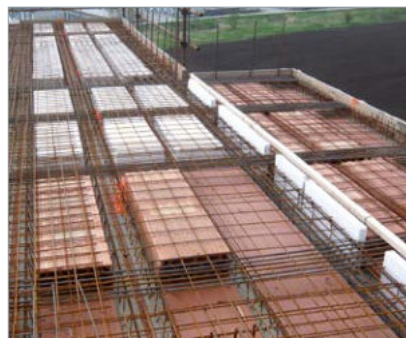
přerušení tepelného mostu mezi balkónem a stropem
