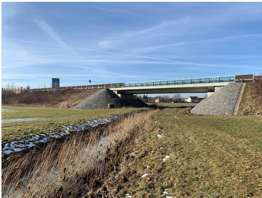
Obrázek 5: Mostní konstrukce typu přímo pojížděného mostu (silniční obchvat města Holic) Zdroj: vlastní zpracování
