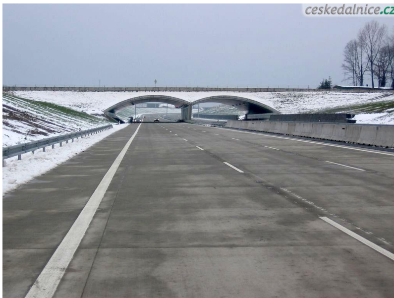
Obrázek 7: Migrační nadchod mostového typu (D1 – ekodukt Hrabůvka)
