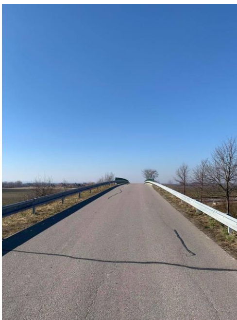
Obrázek 17: Vozovka mostu spojujícího město Holice s městskou částí Roveňsko Zdroj: vlastní zpracování; 2021
