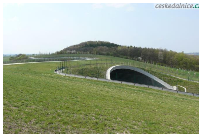
Obrázek 6: Migrační nadchod tunelového typu (D11 – ekodukt Žehuň)
