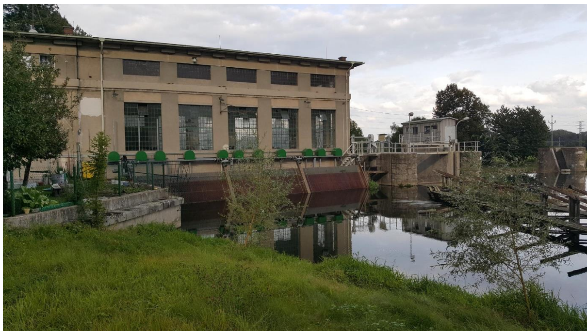
Obr. 7 Pohled na strojovnu
