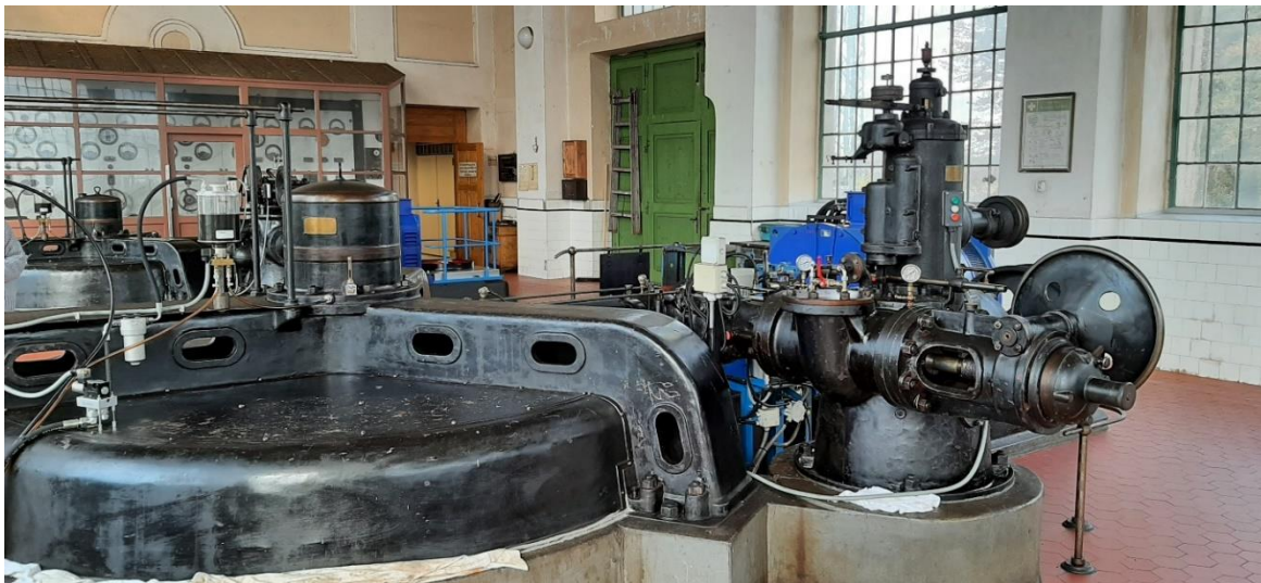
Obr. 9 Kryt převodovky a regulátor otáček
