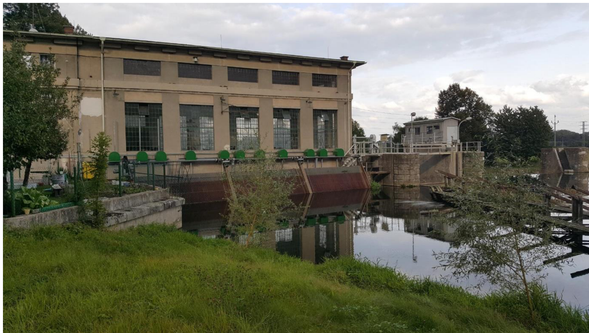
Obr. 7 Pohled na strojovnu
