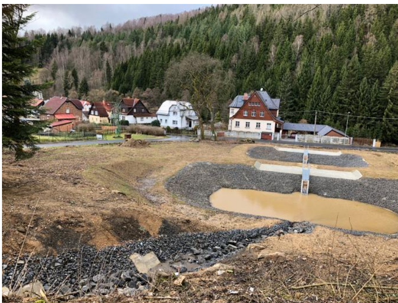
Obr. 20: Stříbrná, zasakovací nádrže, stav po 4 dnech deště (vlastní, 2020).
