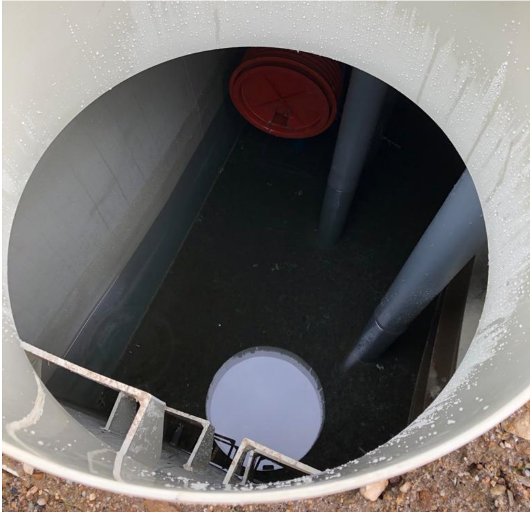
Obr. 18: Stříbrná, přívodní šachta u vodojemu (vlastní, 2020).
