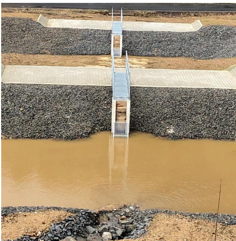
Obr. 21: Stříbrná, zasakovací nádrže, stav po 4 dnech deště (vlastní, 2020).
