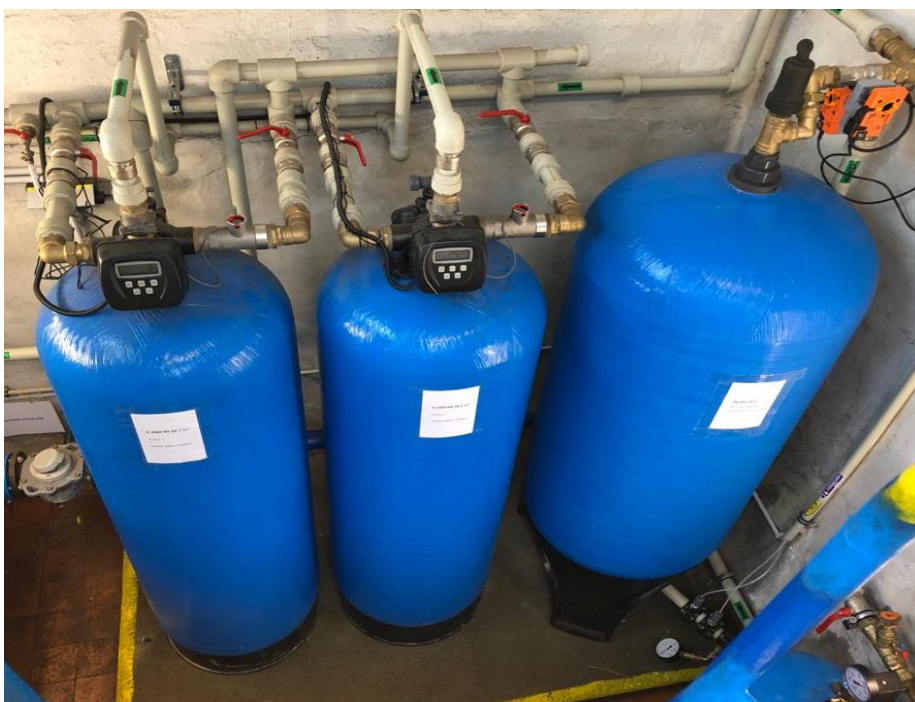
Obr. 16: Stříbrná, odkyselovací místo, vyrovnávací nádoba, reaktor, kde se míchá nadávkovaná chemie pro zvýšení pH. V další nádobě jsou 2 filtry, díky nimž se usadí a vysráží železo a mangan. (vlastní, 2020).
