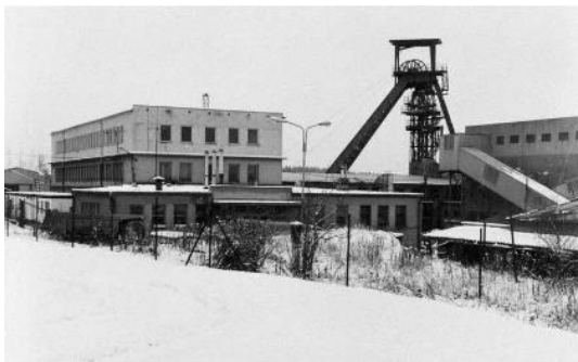
Obrázek U 62: Těžební věž v Horním Benešově
