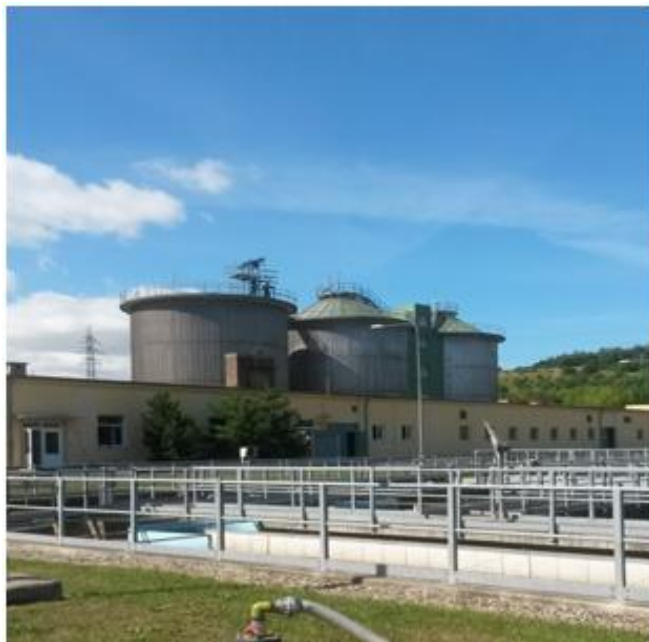
Obrázek 13 - Vyhnivací nádrže a uskladňovací nádrž
