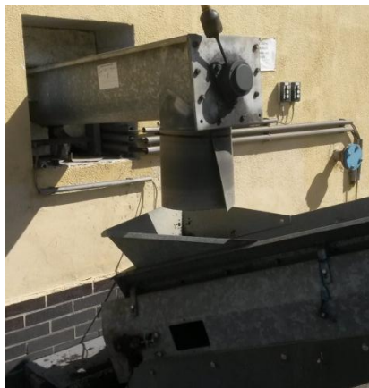
Obrázek 16 - Doprava odvodněného kalu
