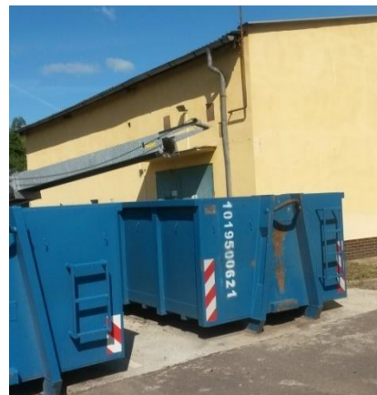
Obrázek 17- Doprava odvodněného kalu
