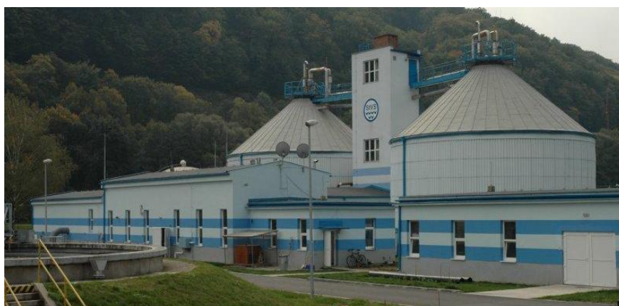
Obrázek 4 - Vyhnívací nádrže (zdroj: Doprastav a.s., 2016)
