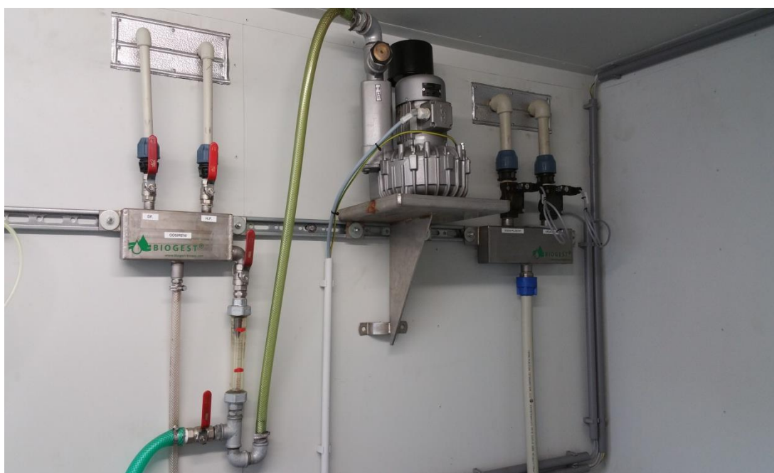
Obrázek 9 - Systém odsíření bioplynu
