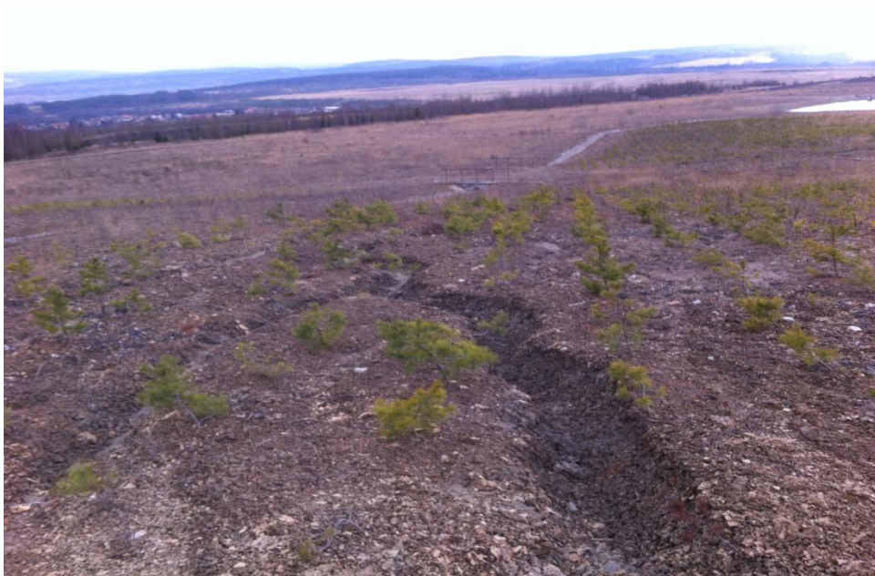
Obrázek č. 10: Erozní rýhy na jižním svahu IX. rekultivační etapy vedle pravé vodní nádrže
