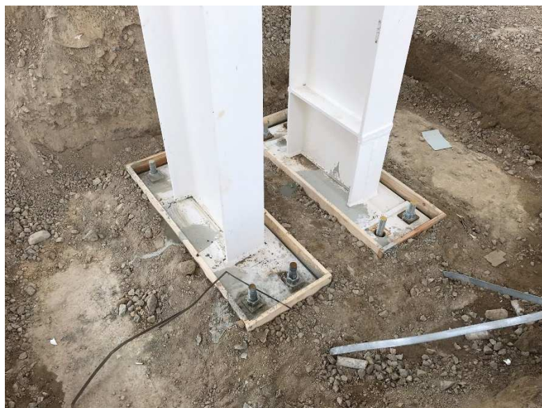
Obrázek 31 - Sloupy opatřené zálivkovou směsí (ilustrační obrázek / vlastní zdroj)
