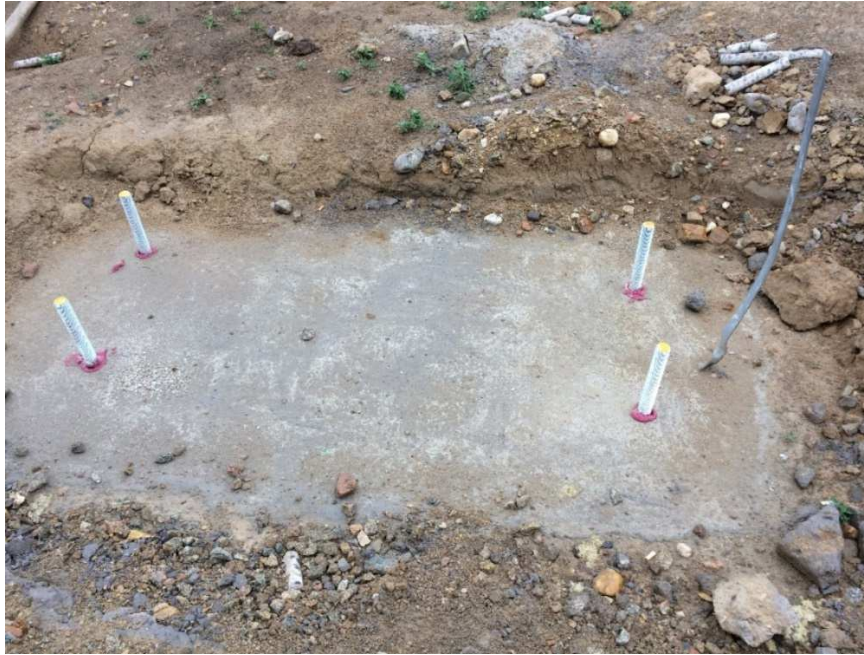
Obrázek 27 - Připravené kotvení pro sloupky a zemní pásek (ilustrační obrázek / vlastní zdroj)
