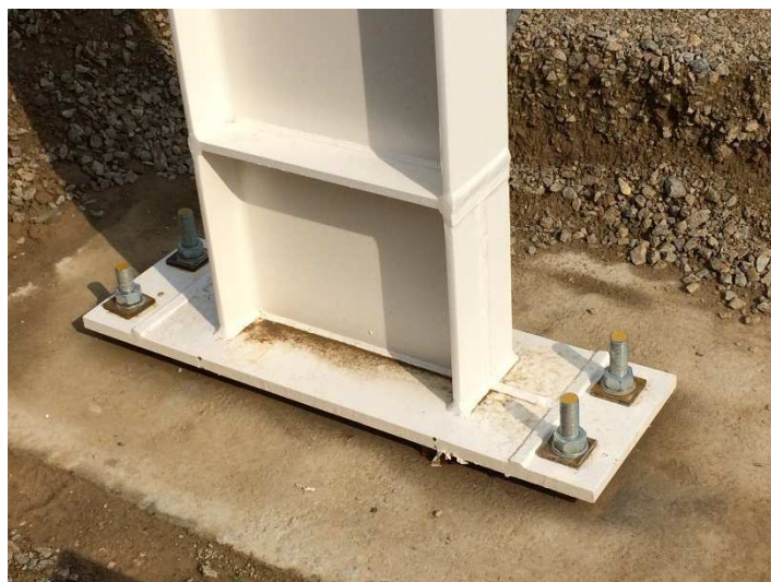
Obrázek 30 - Kotvení sloupu (ilustrační obrázek / vlastní zdroj)
