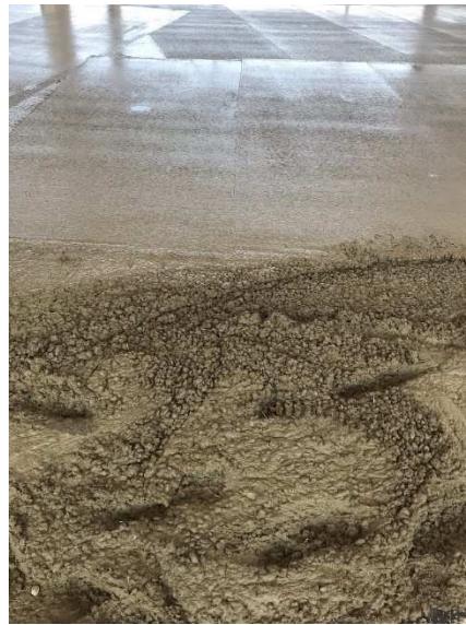
Obrázek 32 - Betonáž drátkobetonové podlahy (vlastní zdroj)
