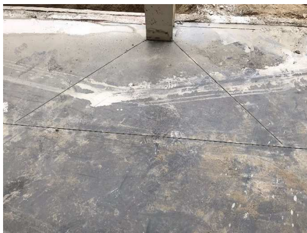
Obrázek 33 - Řešení dilatační spáry u sloupu (vlastní zdroj)
