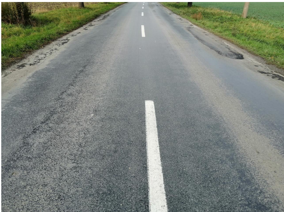
Obrázek 17: Ztráta makrotextury – celoplošné pocení povrchu
