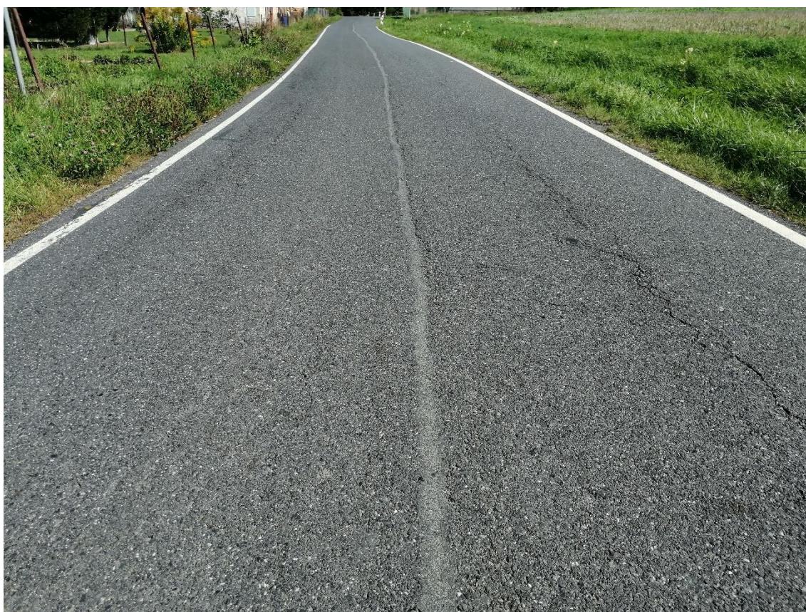
Obrázek 10: Stav 4 - nevyhovující
