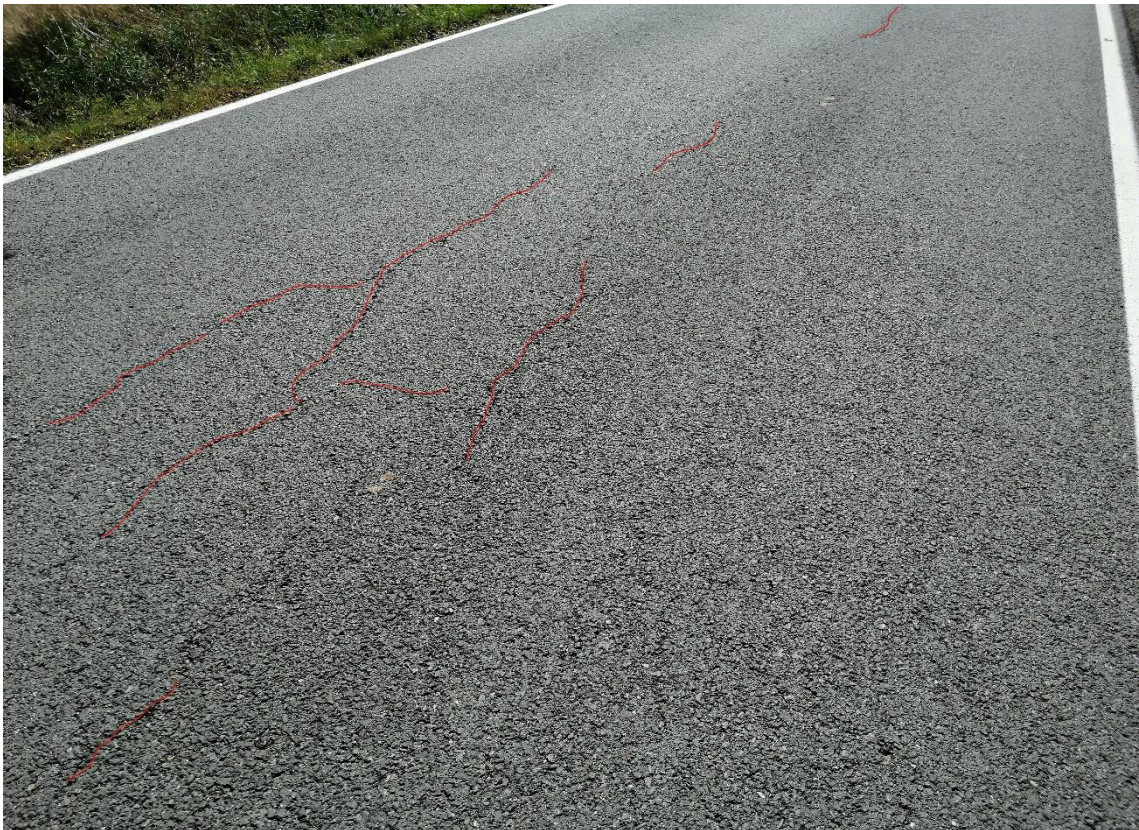
Obrázek 14: Mozaikové trhliny
