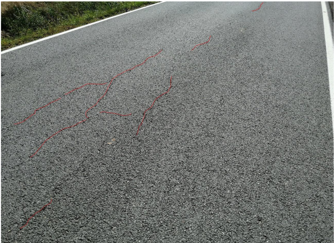
Obrázek 14: Mozaikové trhliny
