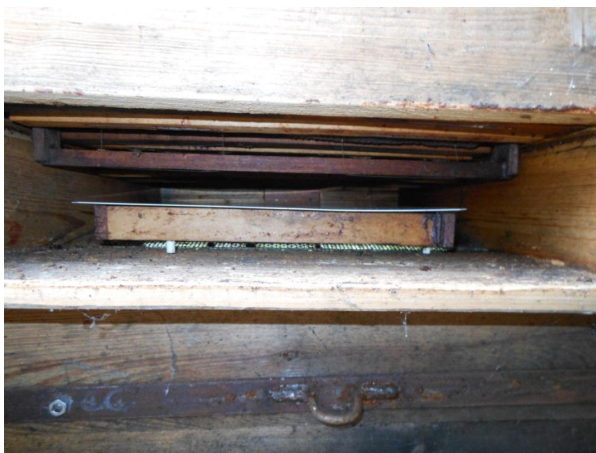
Obr. 21: Instalace podložky v podmetu (Foto: Antonín Tůma)
