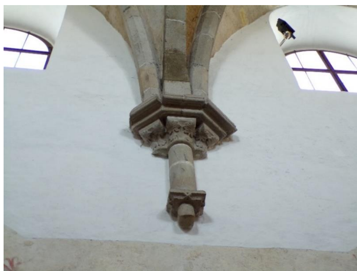
51. Jihlava, kostel Nanebevzetí Panny Marie, listová konzola, západní strana hlavní lodi, kolem 1250
