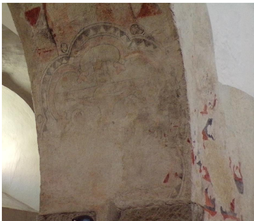
63. Jihlava, kostel Nanebevzetí Panny Marie, Ukřižování na severní straně druhého východního pilíře, 2. polovina 14. století
