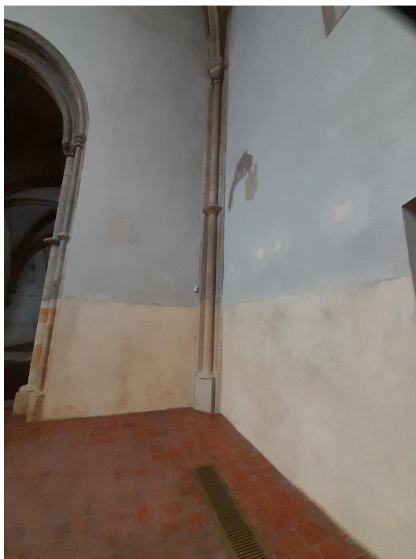
131. Praha, kostel sv. Salvátora při Anežském klášteře, přípory v rohu presbytáře i při triumfálním oblouku přerušené prstenci, výstavba kolem roku 1260
