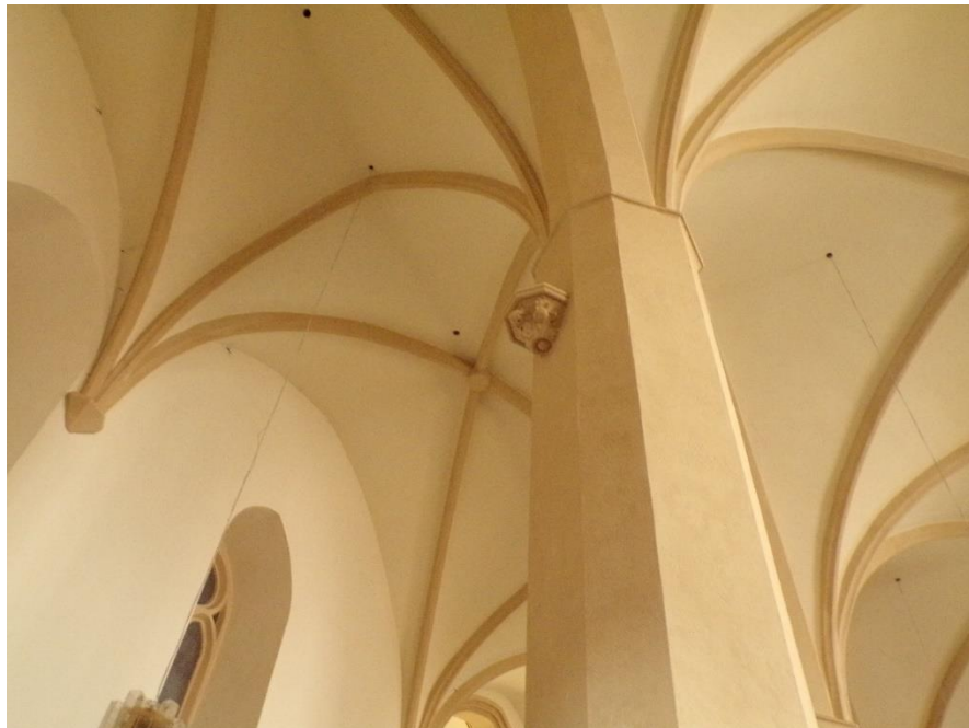
90. Jihlava, kostel sv. Jakuba Většího, pohled na klenbu s parléřovskou konzolou na západním pilíři severní boční lodi, 80. léta 14. století
