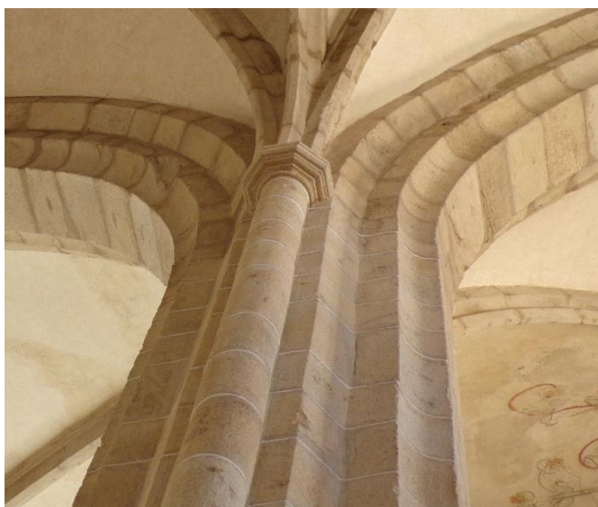
114. Jihlava, dominikánský kostel sv. Kříže, detail jednoho z pilířů trojlodí, asi před polovinou 14. století
