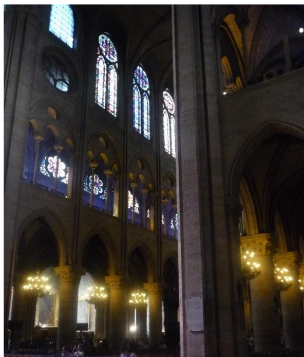
99. Paříž, katedrála Notre Dame, pohled do interiéru s kružbami s vepsaným kruhem, výstavba katedrály od roku 1163
