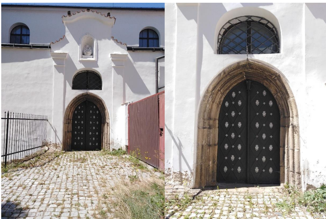
38. Jihlava, kostel Nanebevzetí Panny Marie, východní portál, kolem poloviny 13. století
