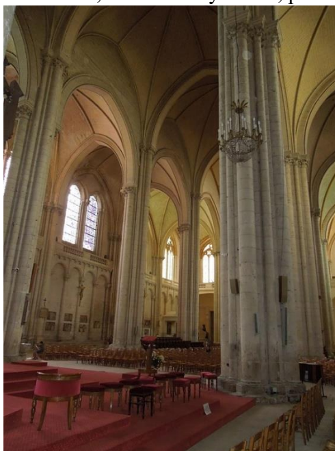
144. Poitiers, katedrála sv. Petra, interiér s halovým zaklenutím, výstavba od roku 1162
