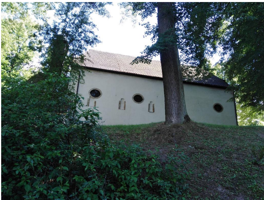
24. Jihlava, kostel sv. Jana Křtitele, severní strana stavby, po polovině 13. století
