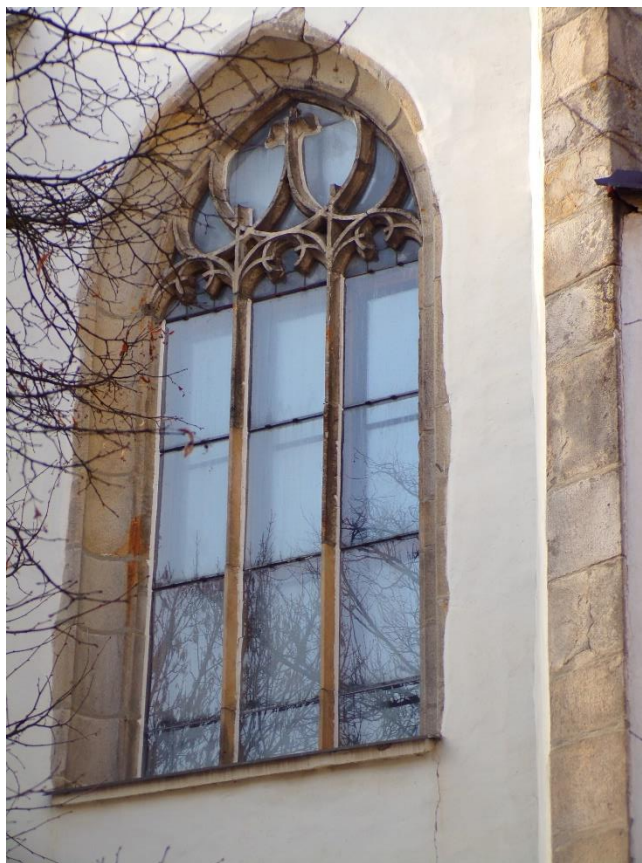
37. Jihlava, kostel Nanebevzetí Panny Marie, východní závěrové okno, mezi lety 1499–1508
