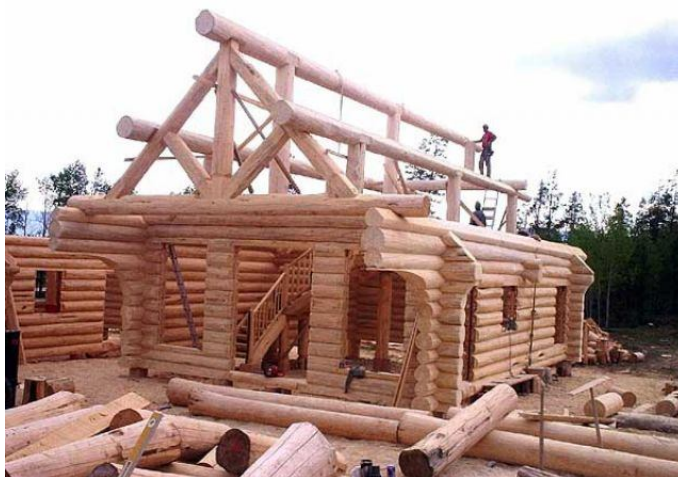
Obr. č. 8 Srubová konstrukce – realizace stavby z nehraněných prvků ( www.drevoastavby.cz )
