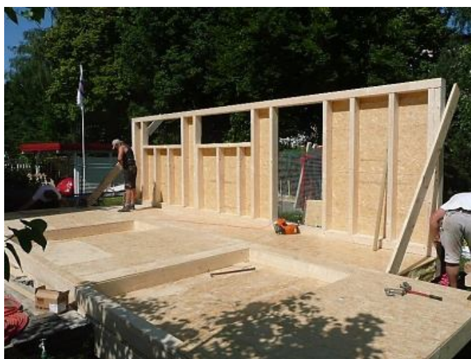
Obr. č. 10 Rámová konstrukce – zajišťování nosného rámu ( www.kodex-reality.cz )
