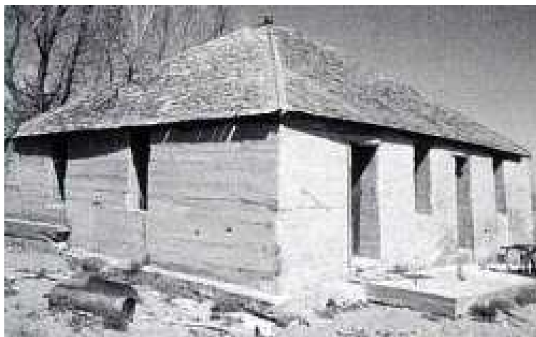
Obr. č. 1 Burke House – zchovalá slaměná konstrukce ( www.thelaststraw.org )
