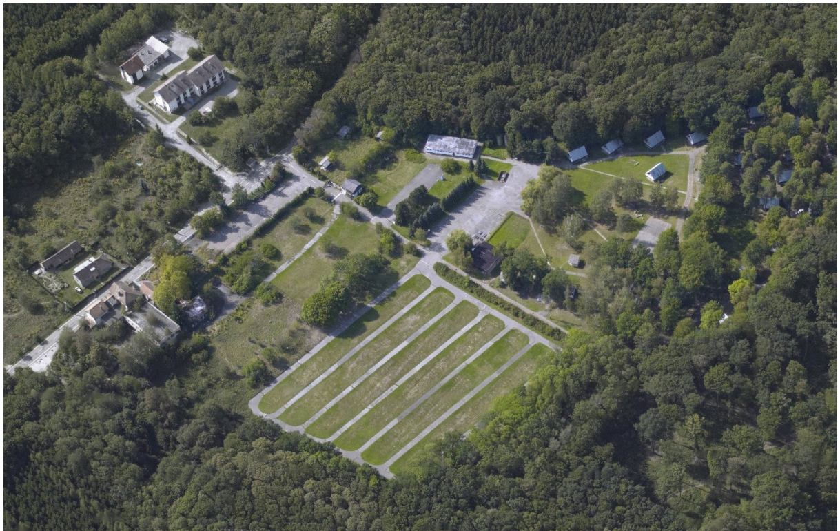
Obrázek 44. ptačí pohled na objekt z východu na západ, současný stav (zpracovala: autorka 2014)
