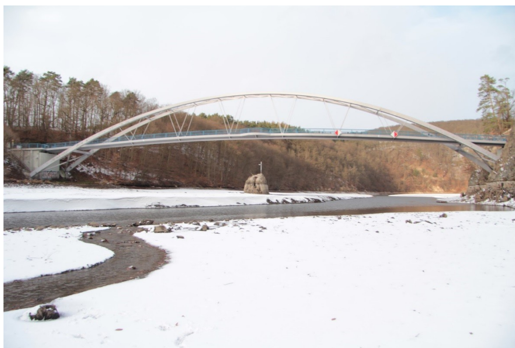
Obrázek 30. Stávající most, postaven roku 2003 (foto: autorka 2014)
