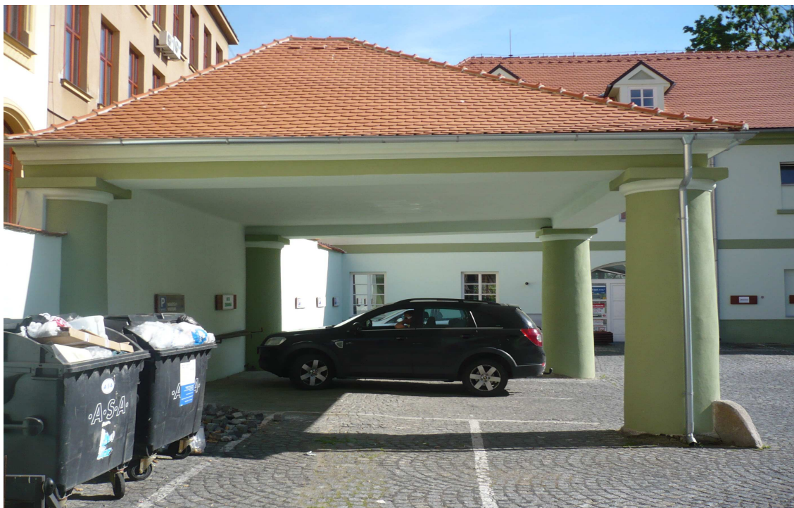
Obr. č. 2 Přepřahací stanice
