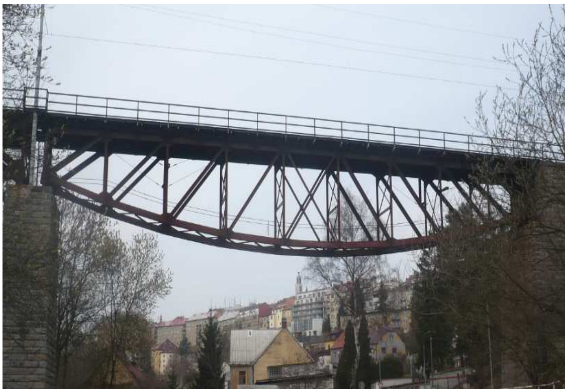
Obr. č. 13 Ocelová konstrukce
