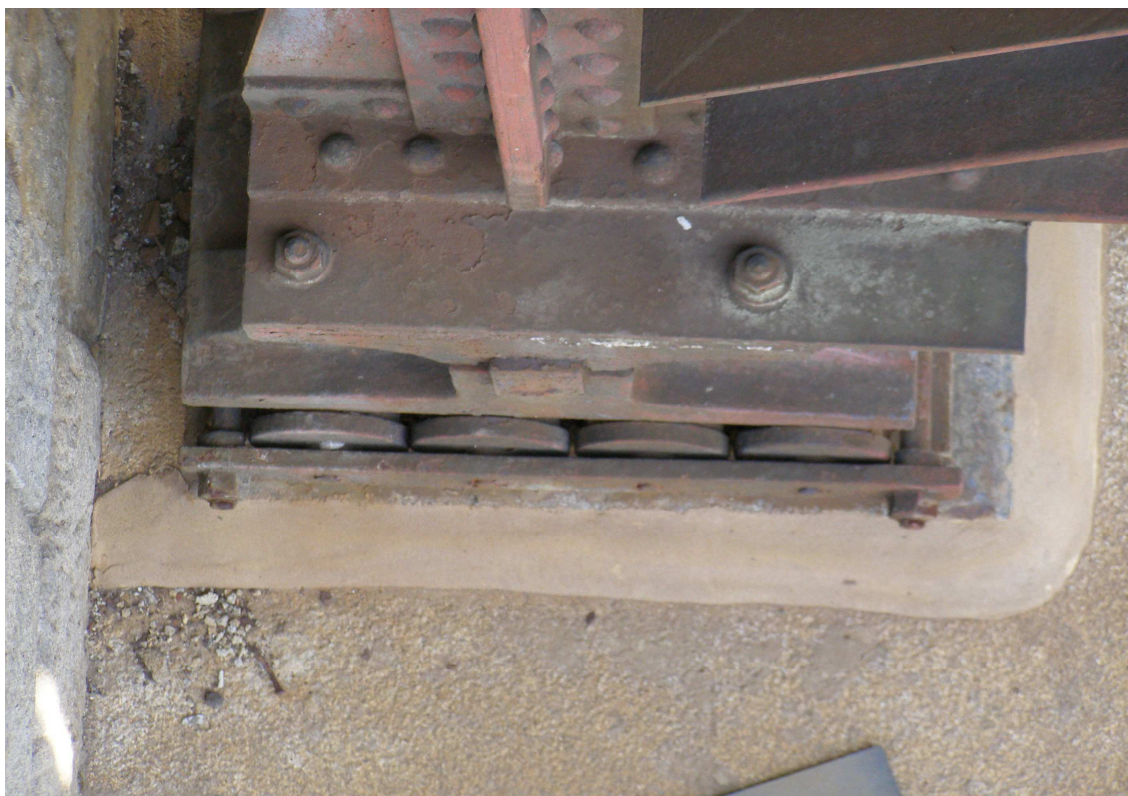
Obr. č. 15 Uložení konstrukce v kamenných pilířích
