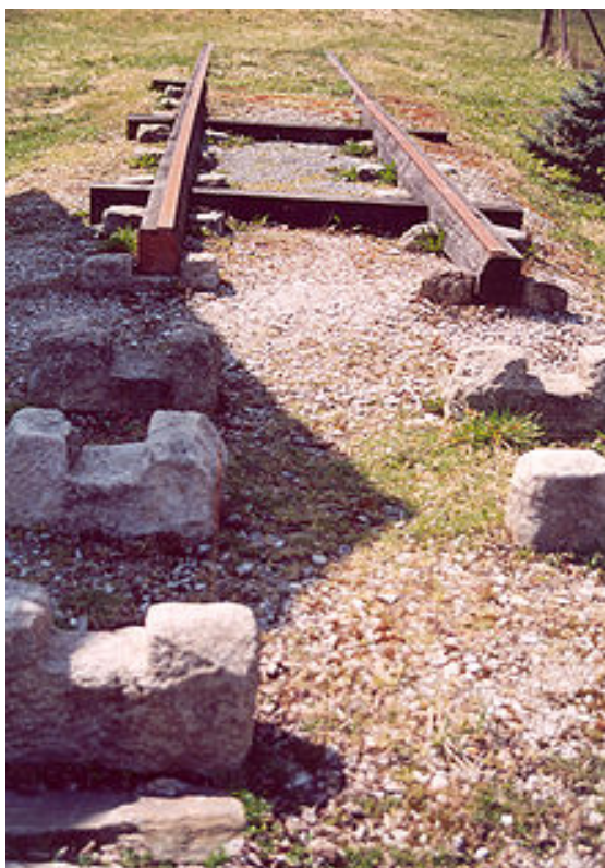
Obr. č. 8 Páskové kolejnice [17]
