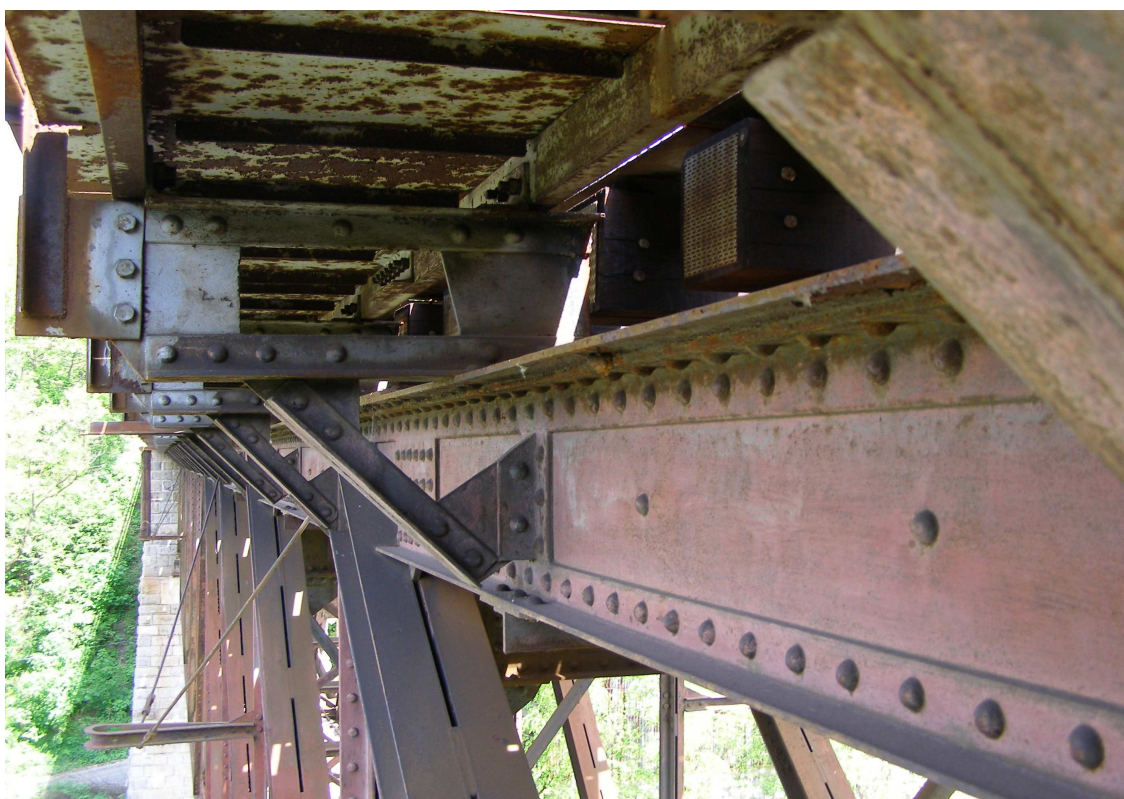
Obr. č. 14 Detail spojení ocelové konstrukce
