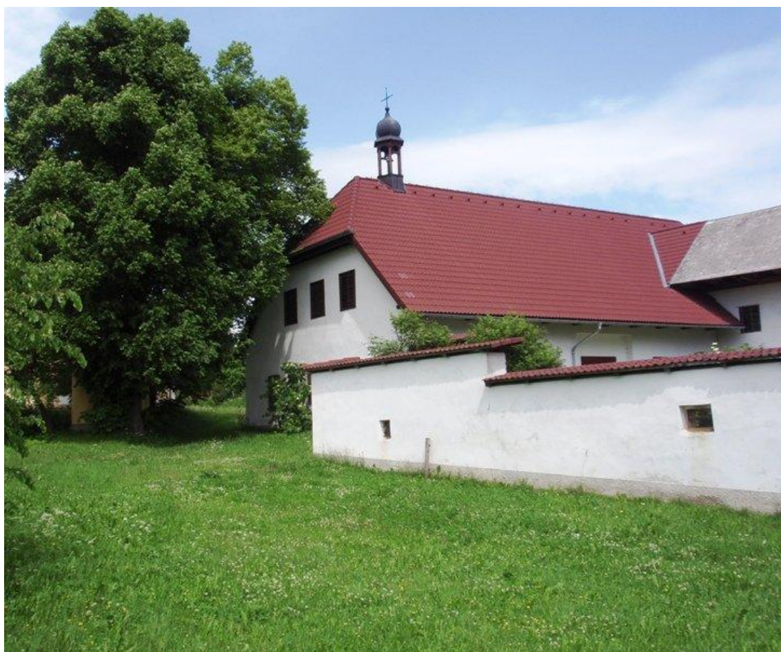
Obrázek č. 14 – Opravené původní stavení v Plešivec (zdroj: zanikleobce.cz)
