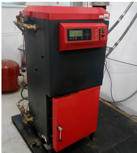
Obr. 7-2 Kotel Verner A251
