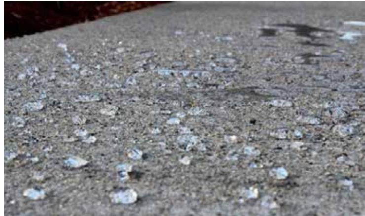
Vodonepropustný beton + hydrofobizační nátěr
