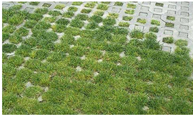
Zpevněné plochy - štěrkový trávník, dlažba s mezerami
