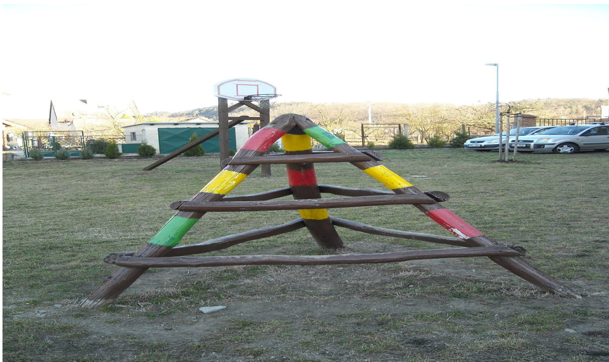
Nové Bránice areál zahrady ZŠ a MŠ.(nevyhovující herní prvek, ostré hrany a spoje)
