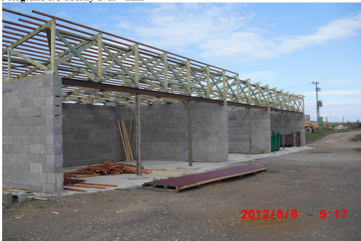
Fotografie č. 3 Sběrný dvůr - hala
