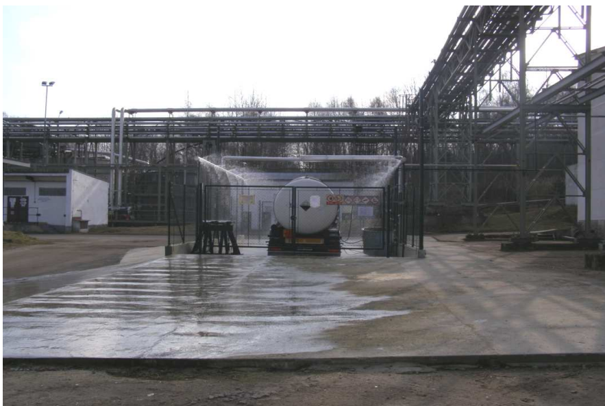
obr. 4 – Skrápěcí systém čpavkového hospodářství
