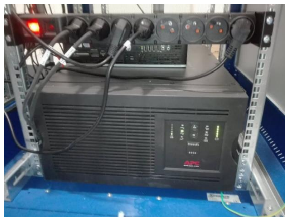
Obrázek č. 15: Záložní zdroj v prostorách firmy
