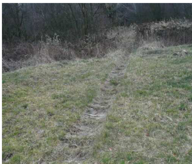
Obr. 10: Neudržované odvodňovací žebro
