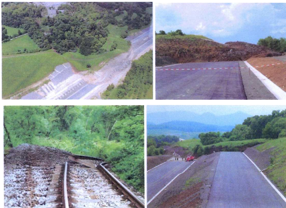
Obr. 1-4: Sesuv na dálnici D8 a poškozená železniční trať
